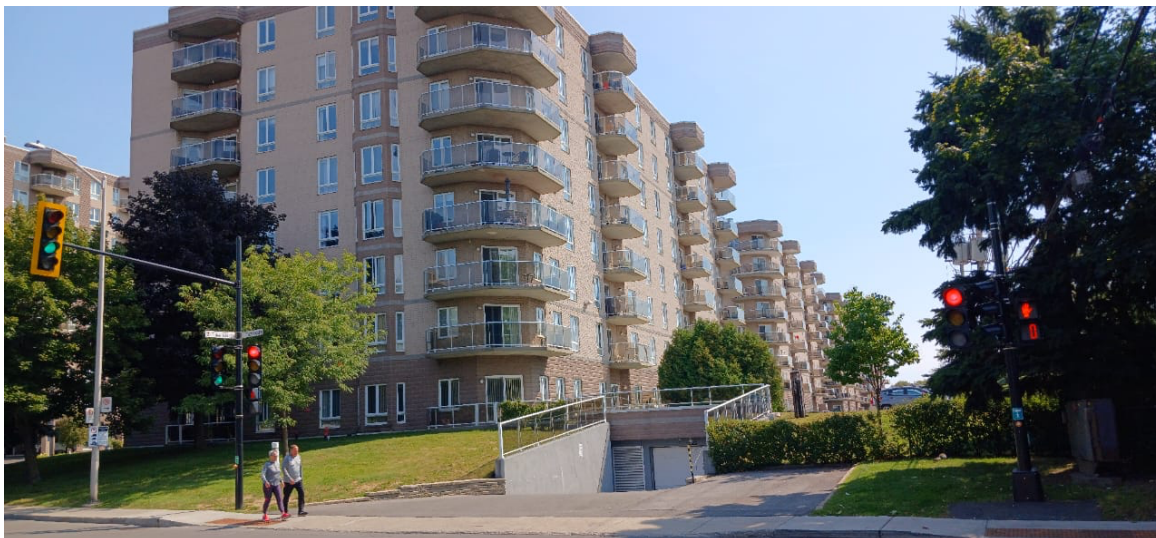
Figure 34 Batiment d'habitation de forte densité dans le kilomètre autour de la station (Moussa Touré, 2025).
