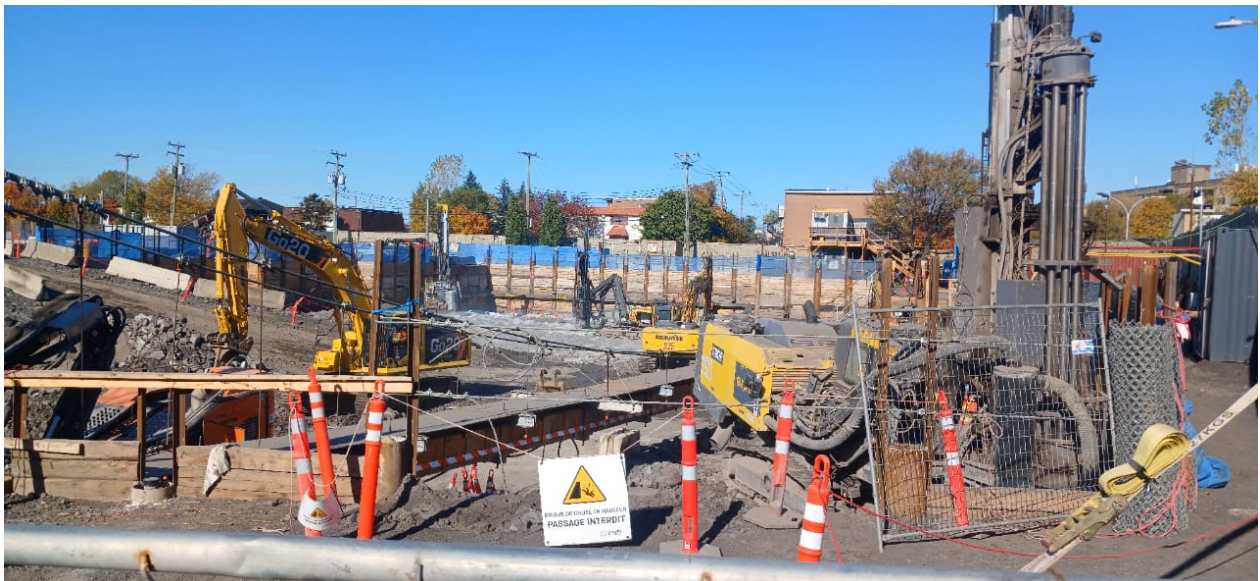
Figure 7 Station Anjou en cours de construction (Moussa Touré, 2025).
