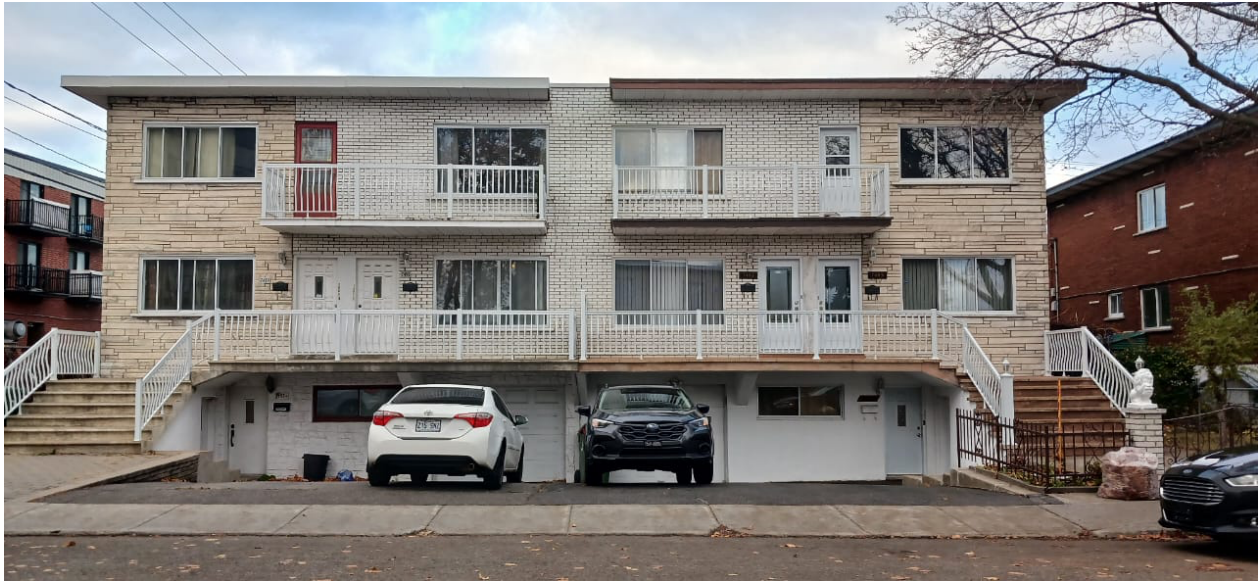
Figure 33 Exemple de bâtiment typique à Langelier (triplex jumelés) autour de la station Madeleine-Parent (Moussa Touré, 2025).
