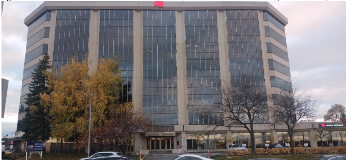
Figure 35 Exemple de batiment de bureaux de grande envergure (Moussa Touré, 2025).
