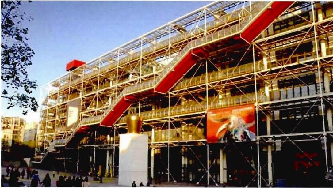
Figure A.3 Le Centre Georges Pompidou. (Tiré de Centre Georges Pompidou, document pédagogique. < http://www.centrepompidou.fr/education/ressources/ENS-architecture-Centre-Pompidou/au_coeur_de_paris/p1.htm >. En ligne.)
