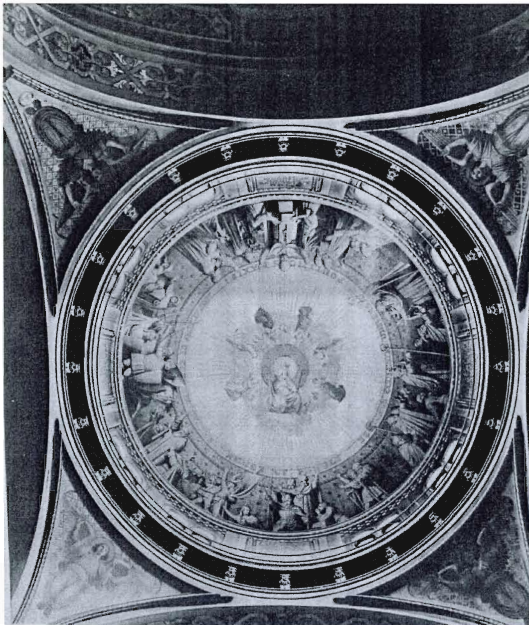
Fig. 25 N. Bourassa, Coupole de la chapelle Notre-Dame de Lourdes , 1880-1882, Chapelle Notre-Dame de Lourdes, Montréal (Photo : Fonds Napoléon-Bourassa, BAC, Ottawa, C-86246).
