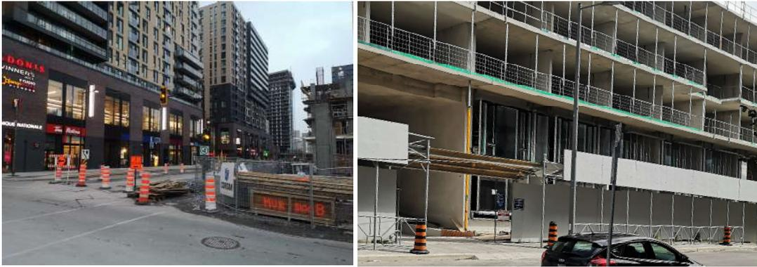
Figure 5.3 Gestion de l'interface entre chantiers de construction et espace piéton à Griffintown (à gauche) et dans les West Don Lands (photographies prises par l'auteur, 2020)
