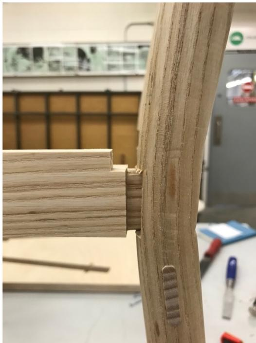
Figure 3.41 Assemblage patte arrière et traverse : Prototype 3
