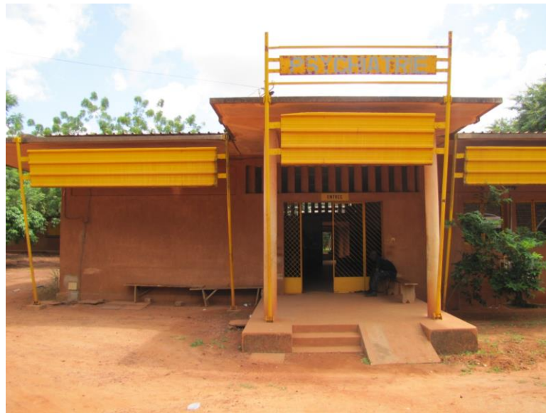
Figure 4.3. Photographie de l'enceinte du service psychiatrique 33
