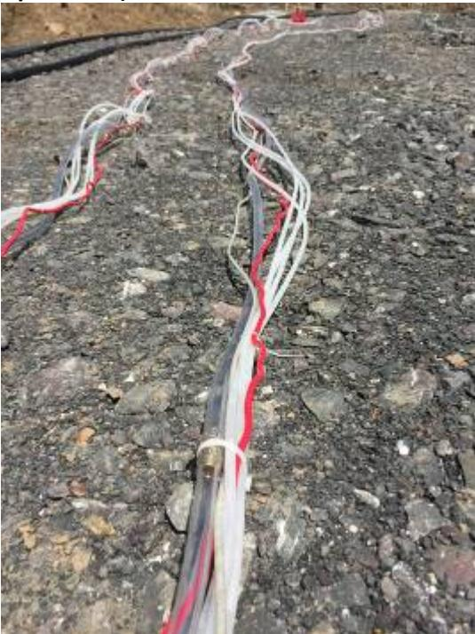
**Photographie 16 :** Plan rapproché de la ligne : faisceaux d'échantillonnage de l'eau à profondeur donnée par micro-pompage, conduite de pompage et câble électrique d'alimentation de la pompe submersible
