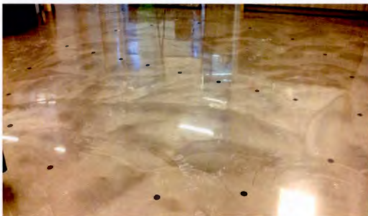
Fig. 4.29. Espace défini dans les installations d'Échofab.
