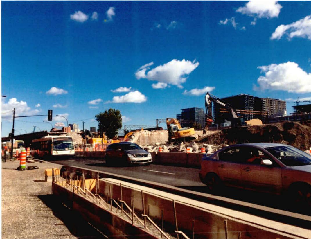
Figure B.17. Projet de rabaissement de l'ancienne autoroute Bonaventure surélevée, en conversion en 2016 et 2017, pour l'aménagement d'un boulevard urbain (vue vers le sud-est).
