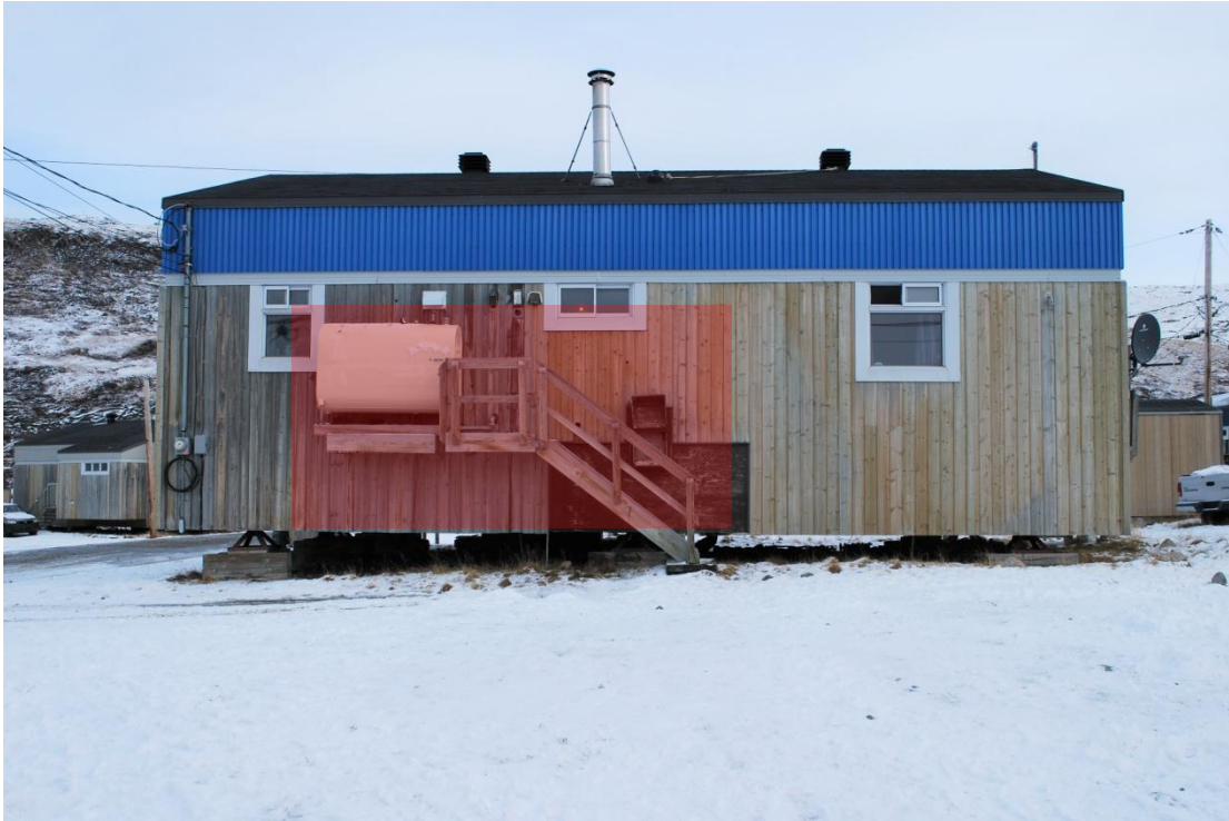
Figure 14: Logement type U3 avec réservoir d'eau accessible
