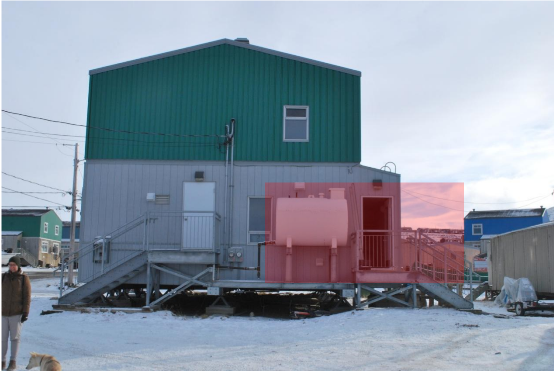
Figure 13: Jumelé avec réservoir d'eau accessible de la rue
