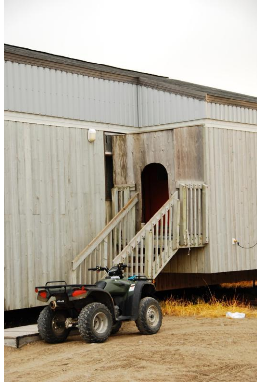
Figure 25: Système protection de l'entrée, Inukjuak 2009. Source: Patrick Evans
