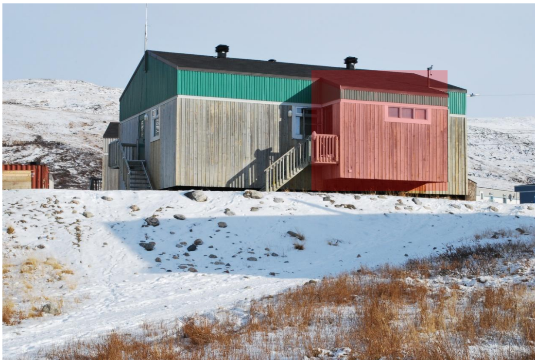
Figure 16: Porche typique retrouvé sur les logements unifamiliales
