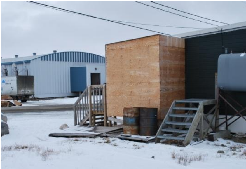
Figure 20: système protection de l'entrée avec panneaux OSB, Salluit 2016. Source: Bianca Robert
