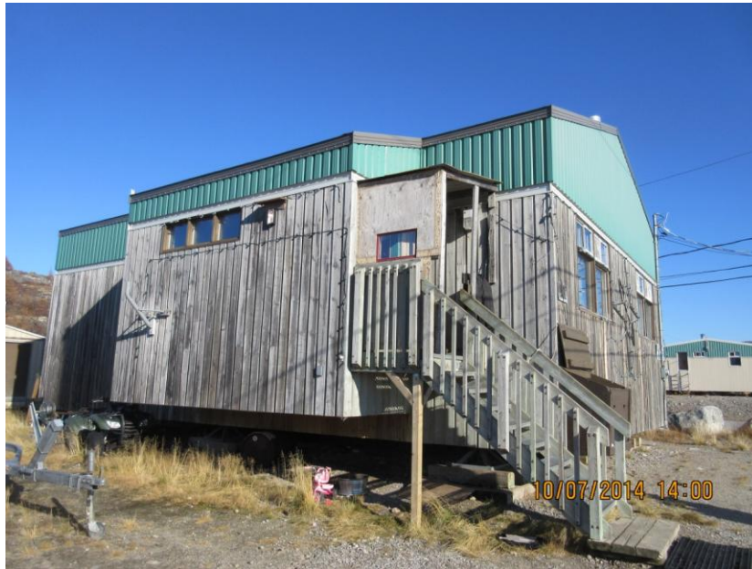
Figure 27: Système protection de l'entrée, Nunavik 2014. Source: SHQ
