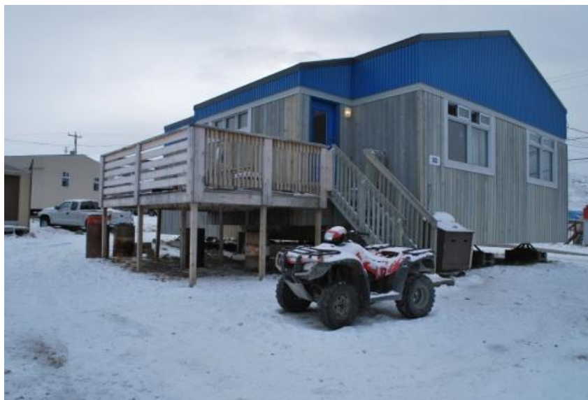
Figure 22: Balcon ajouté à un logement de type U3, Salluit 2016. Source: Bianca Robert
