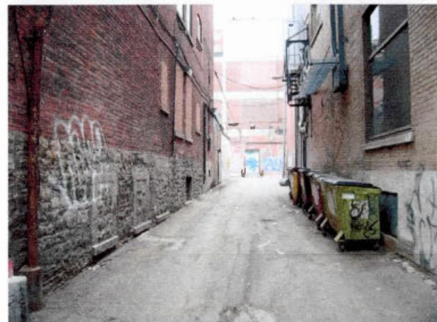
Figure 1.4 Ruelle centre ville, z.b, photographie, Montréal 4/4/2012 Malgré leur revitalisation depuis les années 1980, les ruelles gardent toujours des traces d'un passé proche. (fenêtres emmurées, ajouts aux bâtiments, graffitis, récits et mythes, etc.) Ces divers éléments ainsi que l'ambiance singulière, entre un privé et un public, apparente ces interstices à des lieux anthropologiques.
