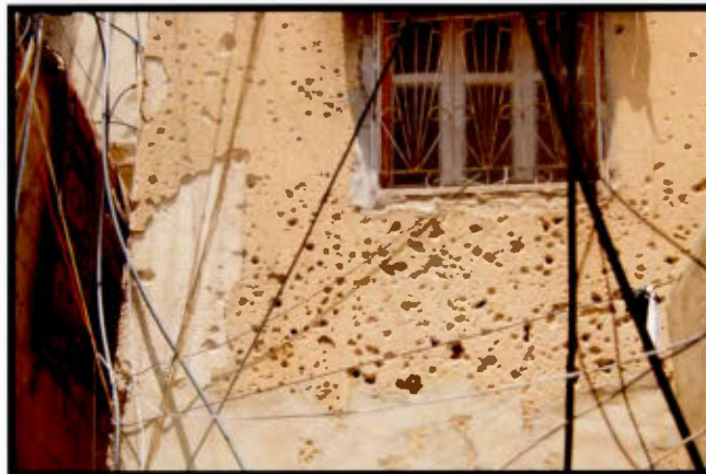
Mur criblé de trous de balles. Bourj el-Barajneh. 2011
