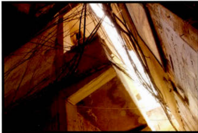
Image des fils électriques suspendus à Bourj el-Barajneh. 2011
