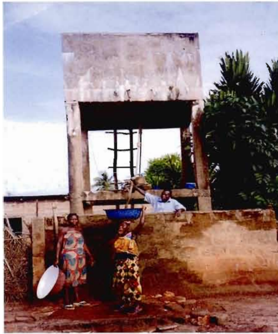
Photo 2.4 Poste d'eau autonome. (Source : MMEH, 2005)
