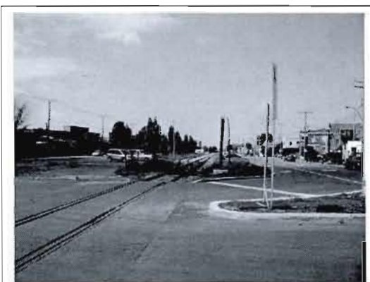
Photo 3.7.3 : Emprise de l'ancienne voie ferrée du CN le long dans l'axe de la rue Victoria. Source : Thomas Bissuel-Roy
