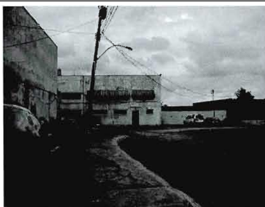
Photo 3.6.2 : Bâtiment vétuste et en apparence abandonné sur la rue Namur tout près de la voie ferrée.
