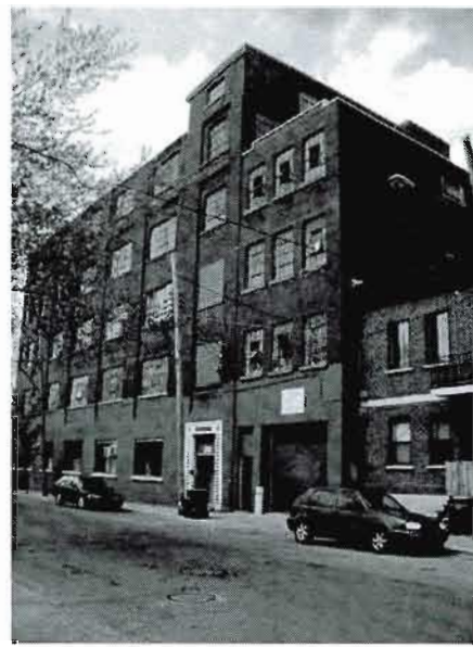
Photo 3.2.1 : Ancien manufacture de vêtement situé à l'angle des rues Ontario et Moreau aujourd'hui occupé par des ateliers d'artistes.
