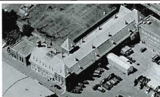
Photo 3.4.1 : Anciennes écuries situées sur la rue des Carrières abritant aujourd'hui des bureaux des travaux publics.
