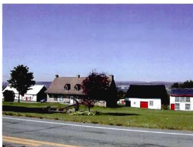
Figure 5.7 : Planche n° 3 – Photo B – Bâtiments agricoles patrimoniaux (ensemble) à Saint-Pierre
