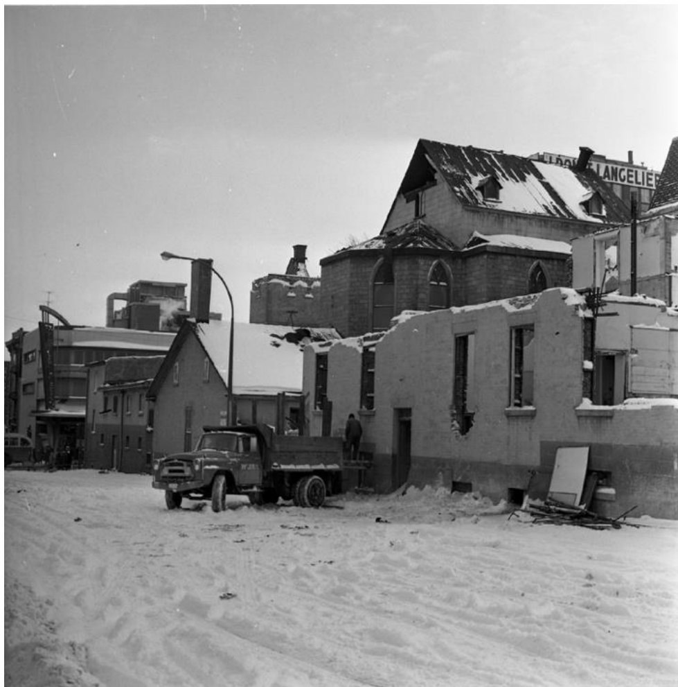
Figure 2.13 : L'Œuvre de la soupe en processus de démolition 134 .
