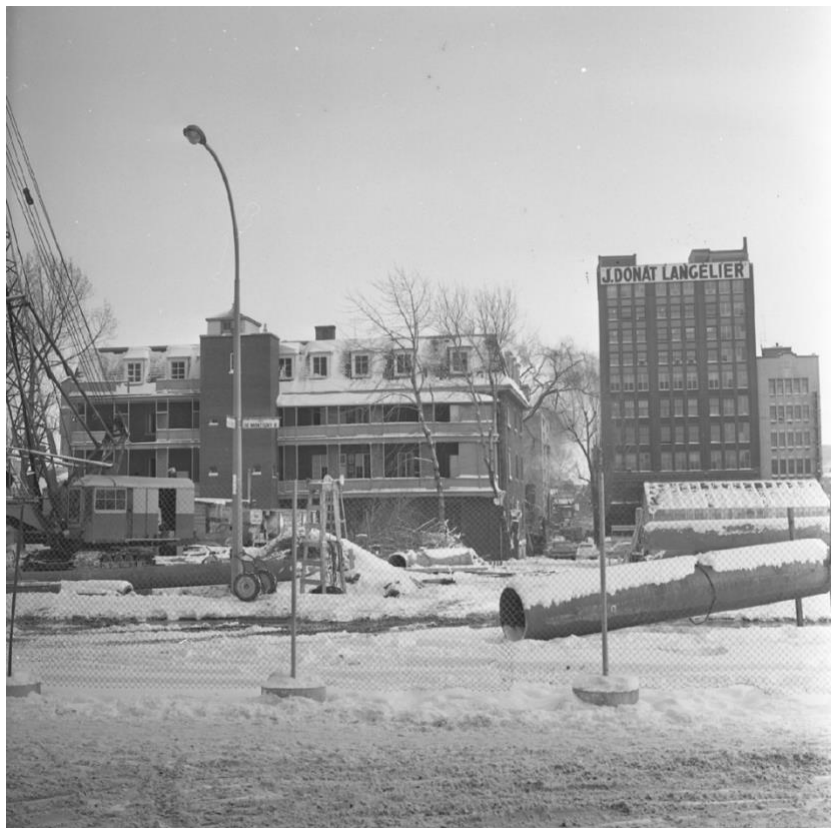
Figure 3.5 : Vue sur l'hospice et sur le bâtiment Langelier le 13 décembre 1963 52 .
