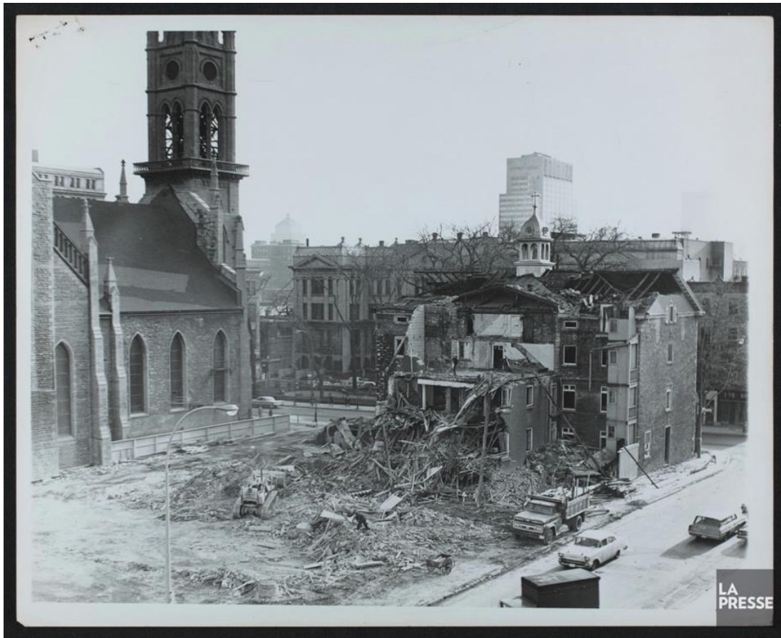
Figure 3.4 : Démolition des Jardins de l'enfance et de l'orphelinat Saint-Alexis 51 .
