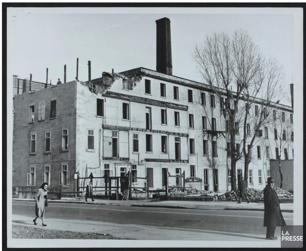
Figure A.6 : Bâtiment où se trouvait l'Œuvre de la soupe 6 .
