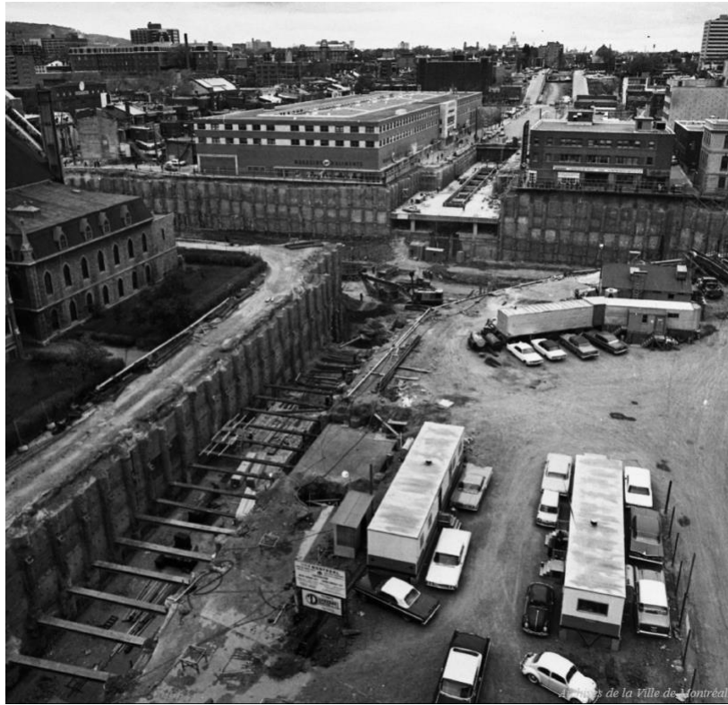
Figure 4.1 : Construction du tunnel de la station Berri-de-Montigny à l'angle de la rue Berri et de l'actuel boulevard de Maisonneuve, 1963-1966 6 .
