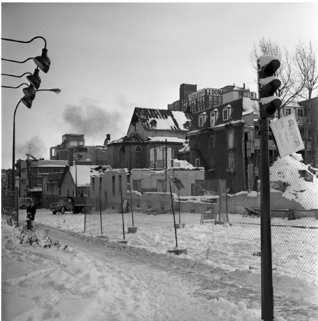
Figure 3.7 : L'Œuvre de la soupe en processus de démolition, vue à partir du coin des rues Saint-Hubert et Maisonneuve 56 .
