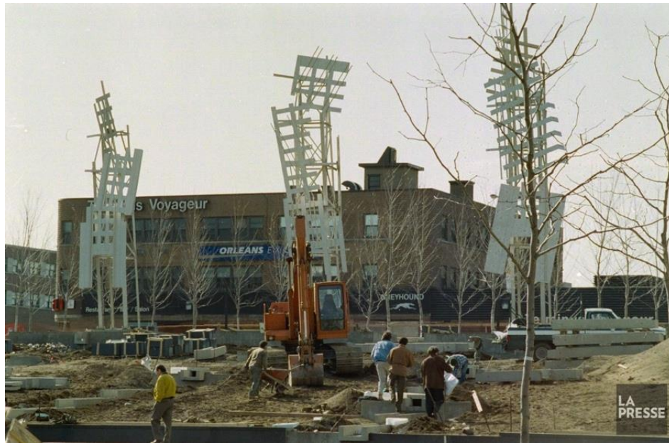
Figure 4.8 : Construction du square Berri 77 .
