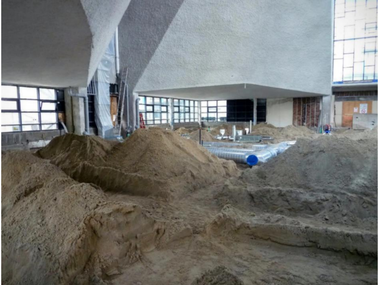
Figure 22. Travaux visant à combler la différence de niveaux , Sainte-Germaine-Cousin - un projet pour la communauté, https://stegermainecousin.wordpress.com/author/pcossette/ .
