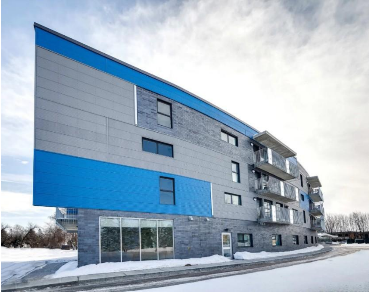
Figure 20. Immeuble d'habitation annexe à l'église Sainte-Germaine-Cousin , Rayside Labossière, https://www.rayside.qc.ca/projets/sainte-germaine-cousin .
