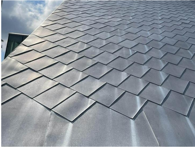
Figure 38. Vue détaillée des nouveaux bardeaux en acier Galvalume plusMC , Achref Toumi, 2025.
