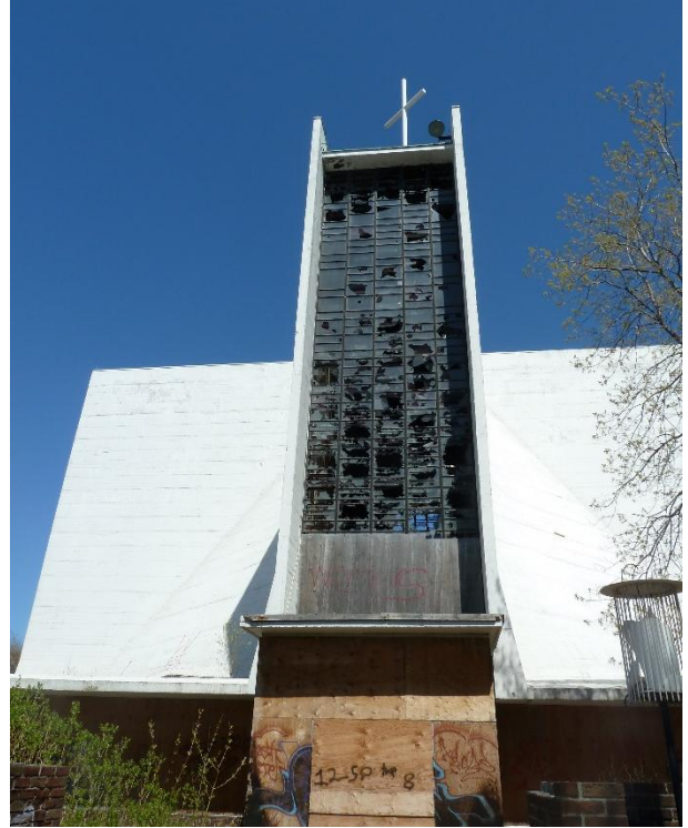
Figure B21. Dégâts subis par les vitraux de l'église Sainte-Germaine-Cousin, Rayside Labossière, 2025.
