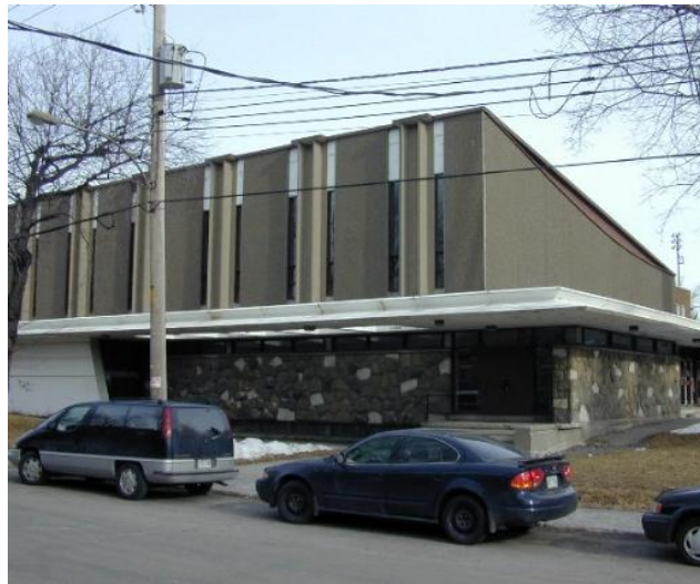
Figure 52. Clichés de l'ancienne église de Saint-Bernard au terme des travaux, Cardin Julien, 2025.
