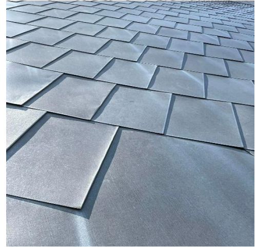
Figure 38. Vue détaillée des nouveaux bardeaux en acier Galvalume plusMC , Achref Toumi, 2025.
