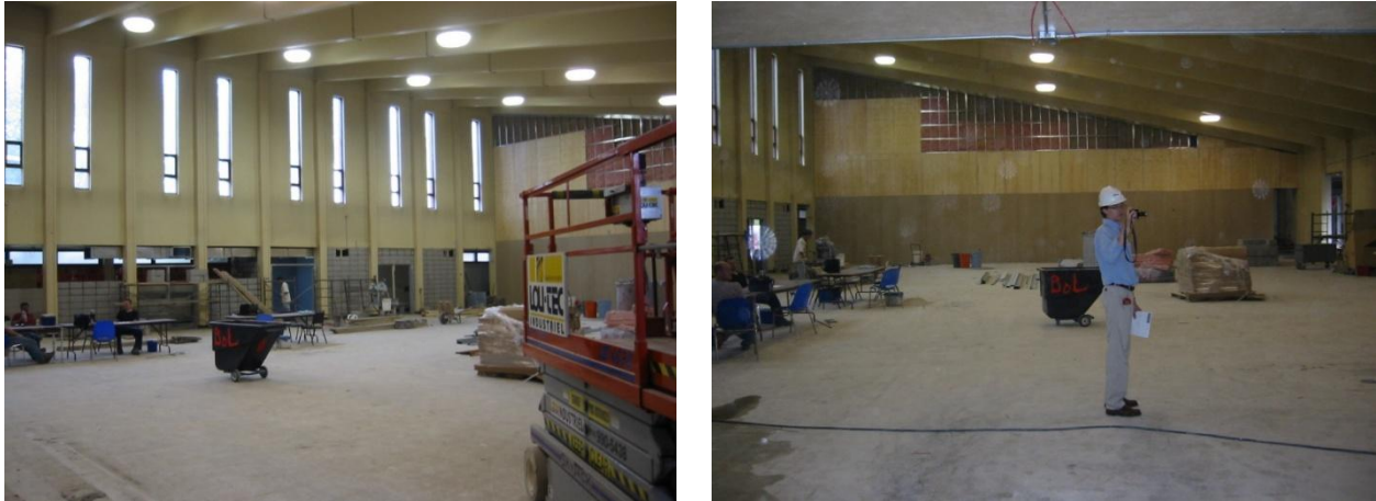
Figure 53. Modifications opérées au niveau de la nef , Cardin Julien, 2025.
