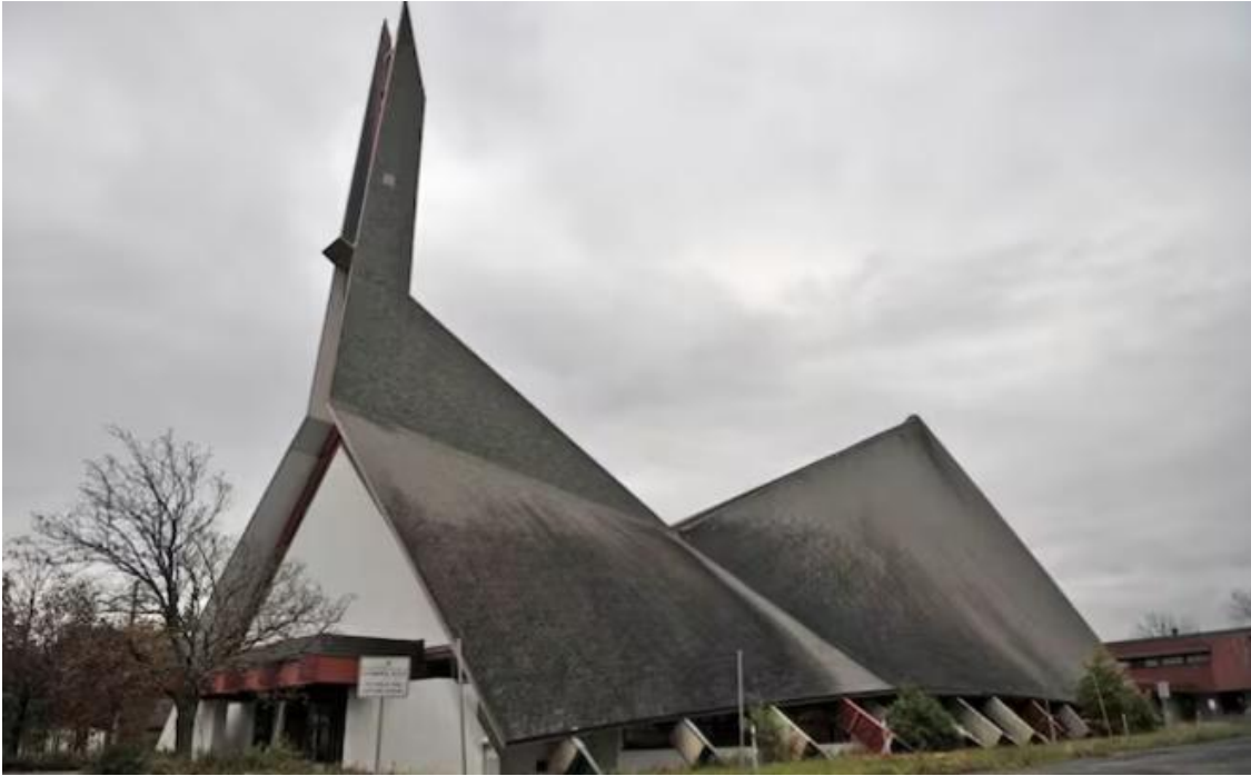
Figure 34. Noircissement de la toiture de l'église au fil des années, Le Soleil, https://www.lesoleil.com/2011/11/09/le-clocher-de-leglise-de-st-denys-du-plateau-consolide-b400490d8d4046052856029581406a15/ .
