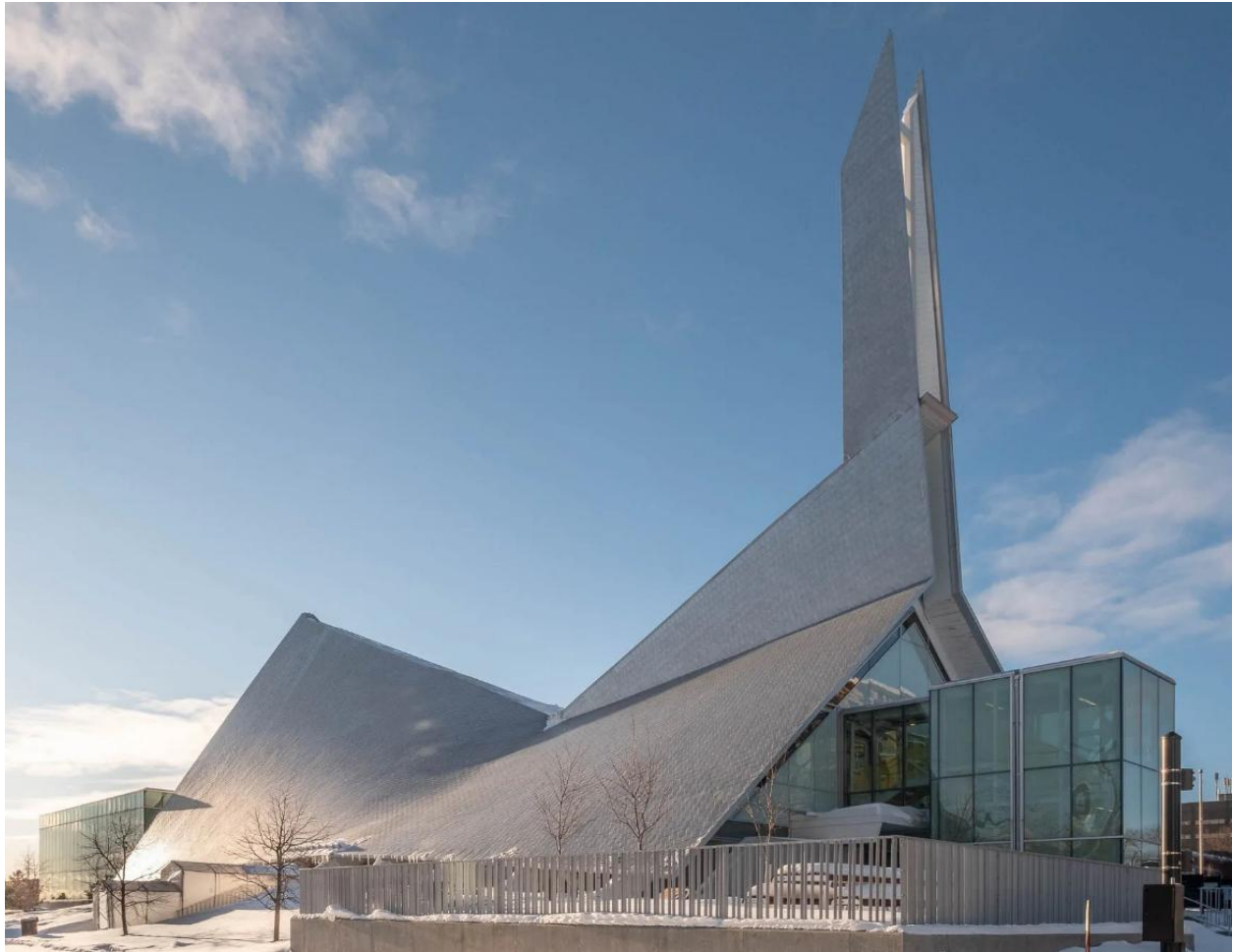
Figure 37. Nouveau traitement appliqué à la coque de l'église , Thomas Guignard Photography, https://thomasguignard.photo/2021/12/01/bibliotheque-monique-corriveau/ .
