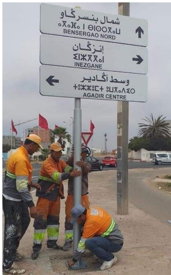
FIG.18 Installation des panneaux au centre-ville d'Agadir. Source : <akalpress.com>
