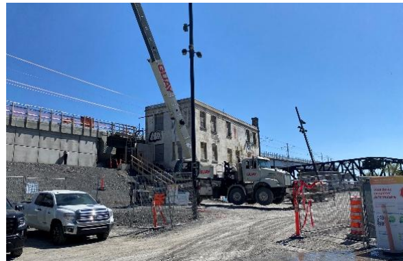
Figure 6.11 Entraves majeures et démantèlement général de la Promenade Smith durant le chantier du REM, en date du 10 mai 2022 ©Ariane Perras
