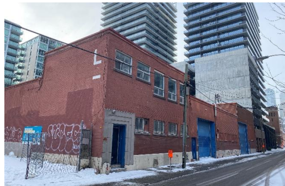
Figure 6.3 Le bâtiment du Projet Young , en attente de sa démolition et de son remplacement par un projet de logement social, en date du 23 janvier 2025 ©Ariane Perras
