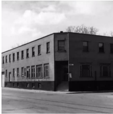
Bâtiment occupé par Quartier Éphémère dès 1994, au 16 rue Prince ©Caroline Andrieux
