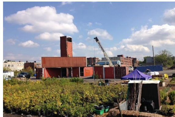
Figure 7.18 Les conteneurs du Virage en construction, en septembre 2016 (Campus MIL – UdeM, 2024)
