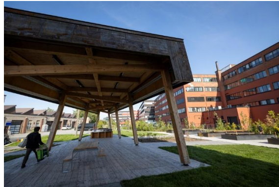
L'Agora : une structure permanente en bois et en métal prévue pour favoriser les usages libres ©Patrick Sanfaçon (Côté, 2024, 21 septembre)
