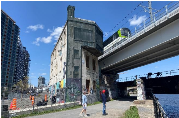
Figure 6.10 Passage des trains du REM sur un nouveau viaduc ferroviaire longeant de près le bâtiment de la Tour d'aiguillage Wellington , en date du 9 mai 2023 ©Ariane Perras
