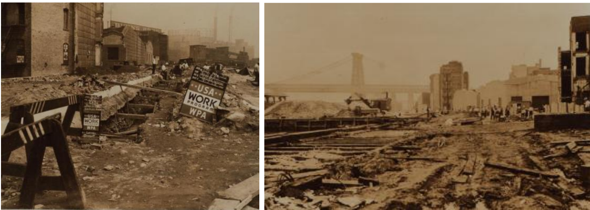
Figures 6.18a et 6.18b Démolition des immeubles au croisement des 3 e et 5 e rues pour accueillir l' East River Drive , 1935. Photographe : Percy Loomis Speer. Gauche : « Manhattan: East River Drive – 3 rd Street (East) », 202b77f0-c54d-012f-0886-58d385a7bc34, Irma and Paul Milstein Division of United States History, Local History and Genealogy, New York Public Library . Droite : « Manhattan: East River Drive – 5 th Street (East) », 216a6db0-c54d-012f-f2f7-58d385a7bc34, Irma and Paul Milstein Division of United States History, Local History and Genealogy, New York Public Library
