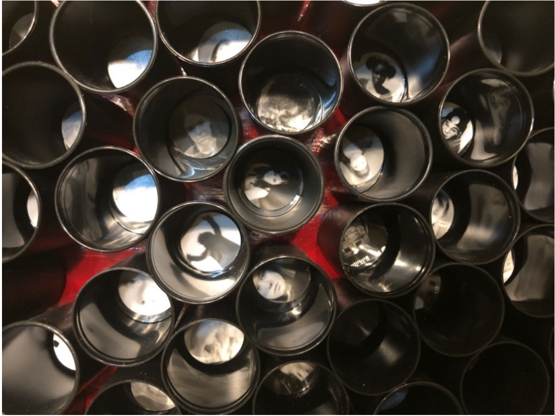
Figure 83 – Détails de l'installation n° 16 Surcharge .
