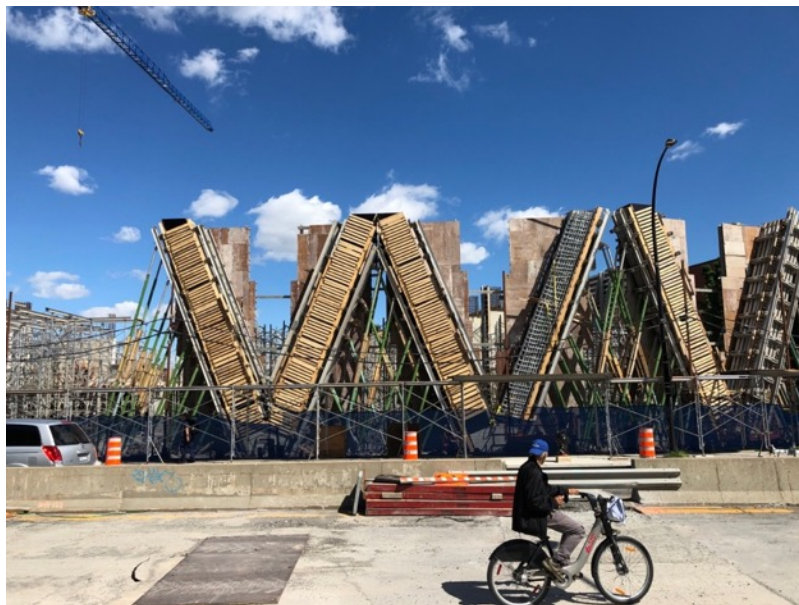
Figure 54 – Dynamique interstitielle. Structures du pont Samuel-De Champlain, 2022.
