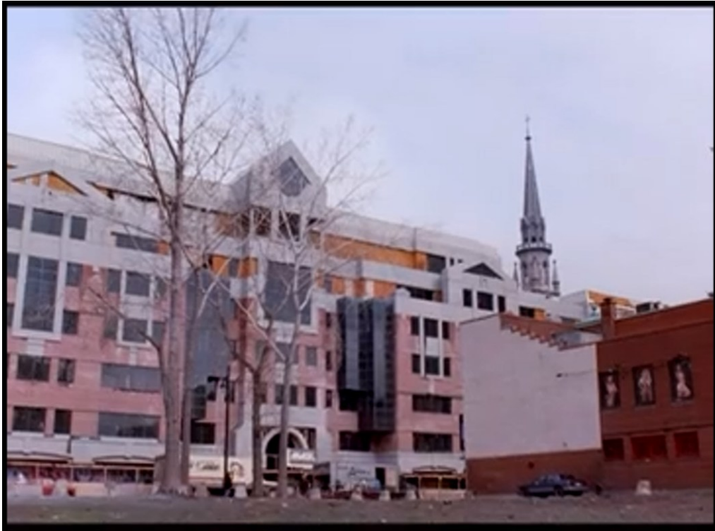
Figure 3.6 Le pavillon de l'École des sciences de la gestion (ESG) de l'Université du Québec à Montréal (UQAM) en construction en 1991-1992 ( Les amoureux de Montréal , 1992, Jacques Giraldeau)
