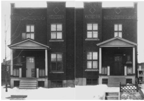
Figure 1.2 Maison construite sur l'avenue Mercille en 1922 pour la Park Housing
