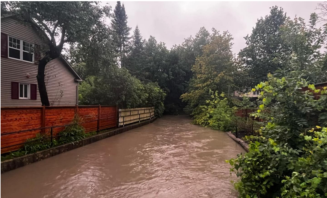
Figure 7 : Tronçon bétonné de la rivière aux Chiens à Sainte-Thérèse (Desjardins, 2024)
