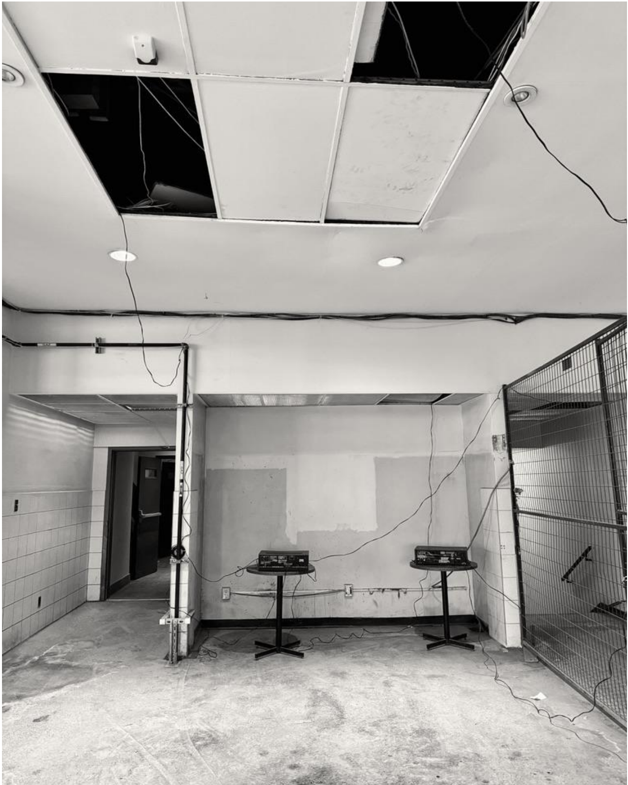
Figure 3.32 Détail de l'installation, des haut-parleurs, dont on voit les fils, derrière le plafond suspendu ©FIZA 2024
