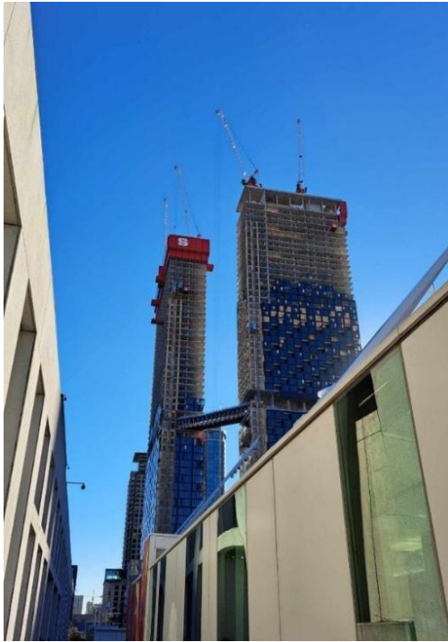
Vue sur la construction des condominiums Maestria, par Rose Gangl-Chartrand, 2022.
