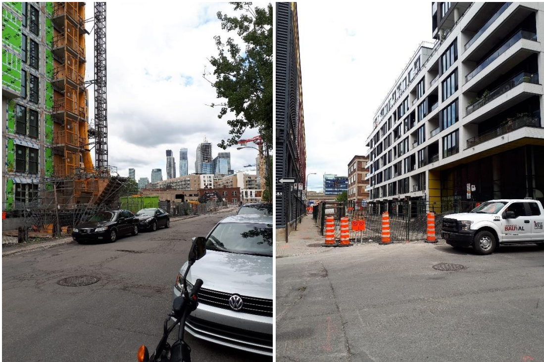
Figure 6.5. Le secteur Peel-Wellington : des chantiers qui empiètent sur les voies de circulation automobile, cyclable et piétonne (Autrice, 2018)
