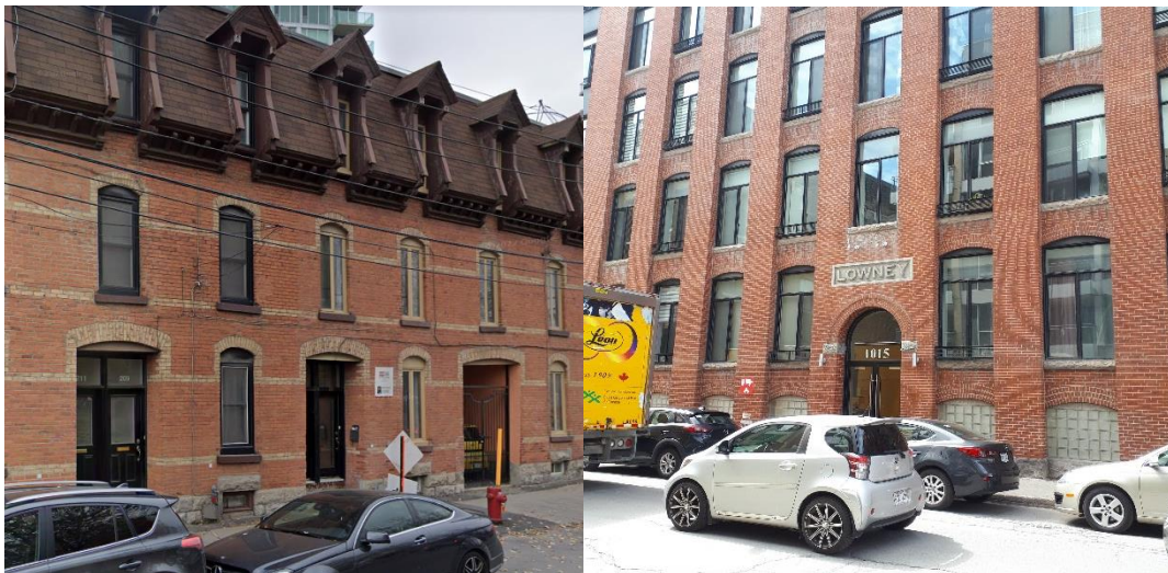
Figure 5.2. Les maisons de rang de la rue de la Montagne (à gauche) et la façade du projet Lowney (à droite), des témoins du passé industriel de Griffintown (Autrice, 2018)
