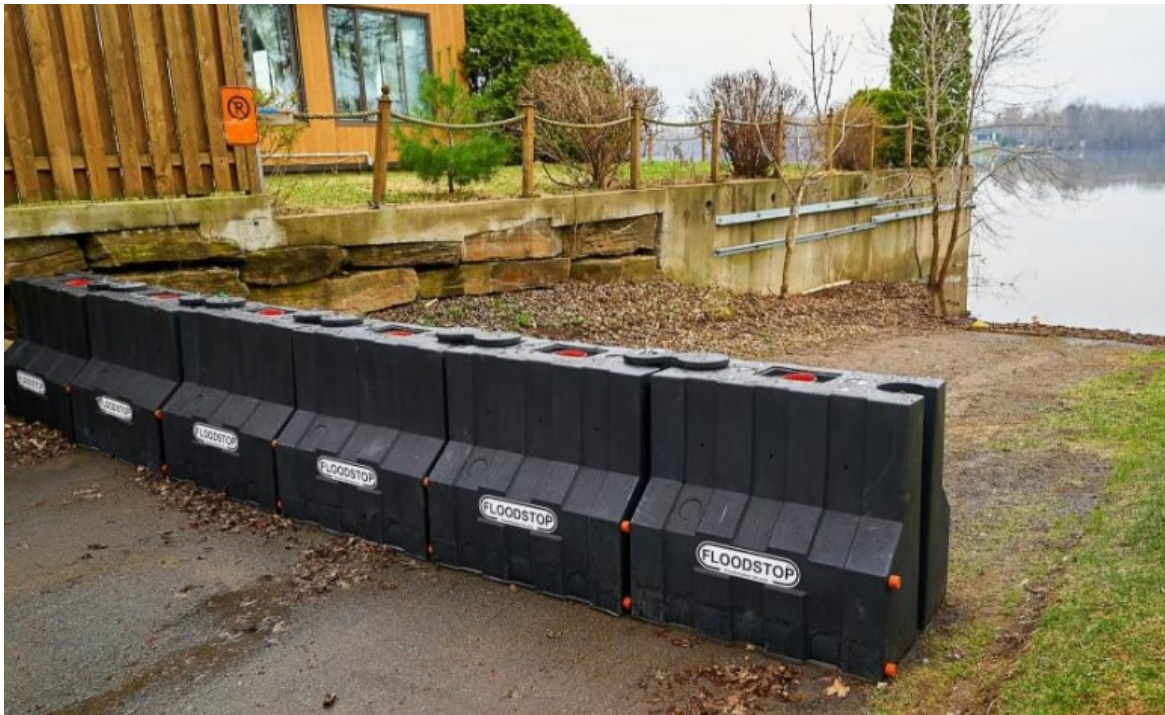
Figure 1.3 Exemple de digue mobile modulaire installée en contexte résidentiel : une alternative plus rapide et réutilisable aux sacs de sable (Normandin, 2018)
