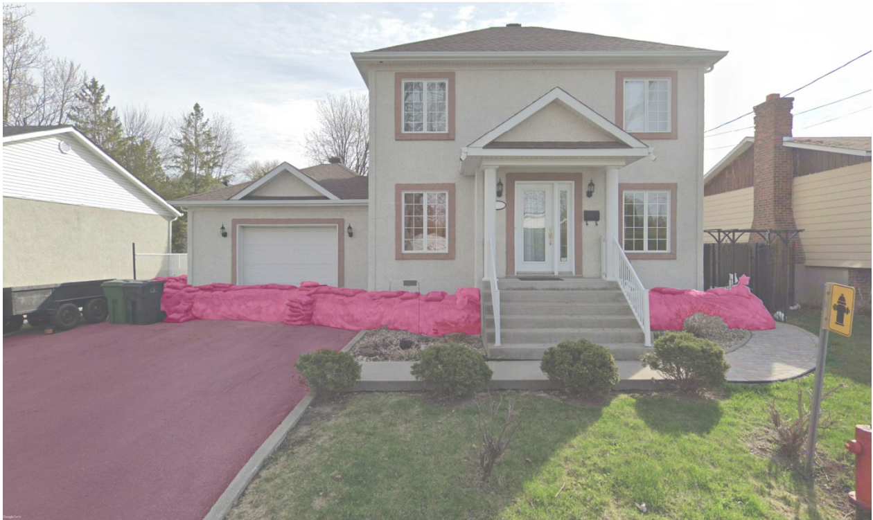
Figure 3.3 Image représentative du cas 1 : maison unifamiliale à 2 étages avec sous-sol et garage accolé (crédit : Google Street View, mai 2019 et Joelle Kelzi)
