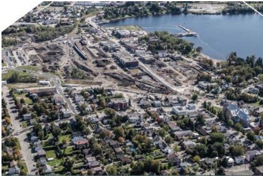
Figure 4.1 Centre-ville historique de Lac-Mégantic détruit avant la démolition des bâtiments contaminés
