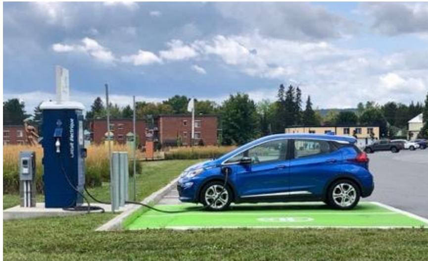
Figure 6.7 Borne électrique située dans le centre-ville de Lac-Mégantic (2021)
