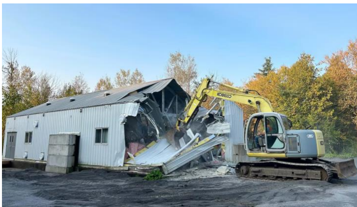
Figure 3.7 Démolition du dernier bâtiment de la GRC au chemin Roxham
