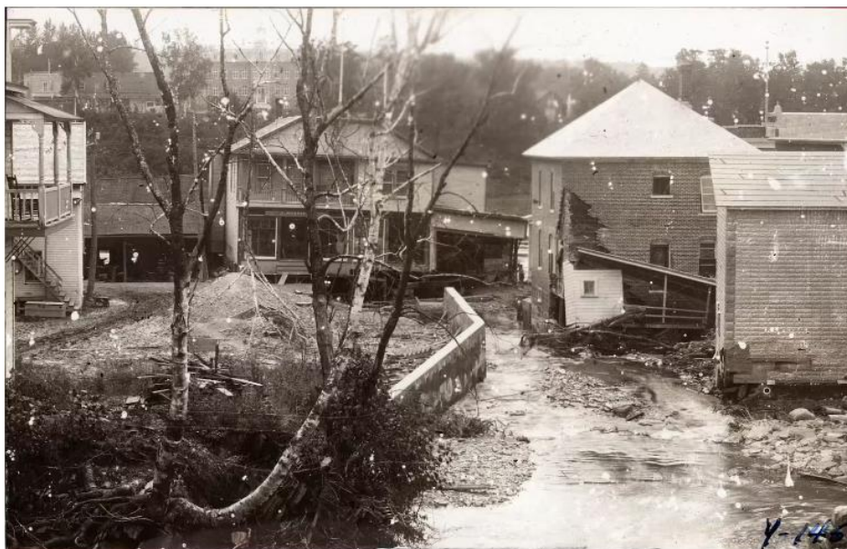
Figure 4.12 Dégâts à Saint-Georges suite à l'inondation du 31 juillet 1917 (BANQ, s.d.a).
