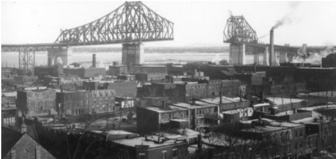
Figure 1.2 Le pont Jacques-Cartier, 1929. Compagnie Dominion Bridge. Bibliothèque et archives Canada. 7
