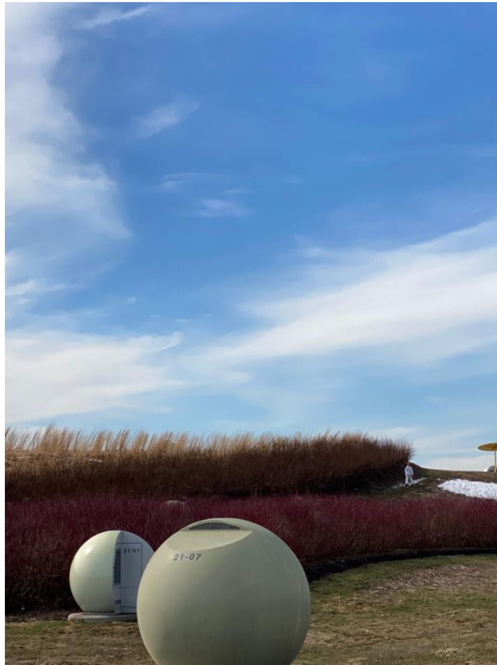
Figure 2.7 Les stations sphériques de collecte de biogaz, photo prise lors de tournage, parc Frédéric-Back, Montréal, photo : Vickie Grondin.
