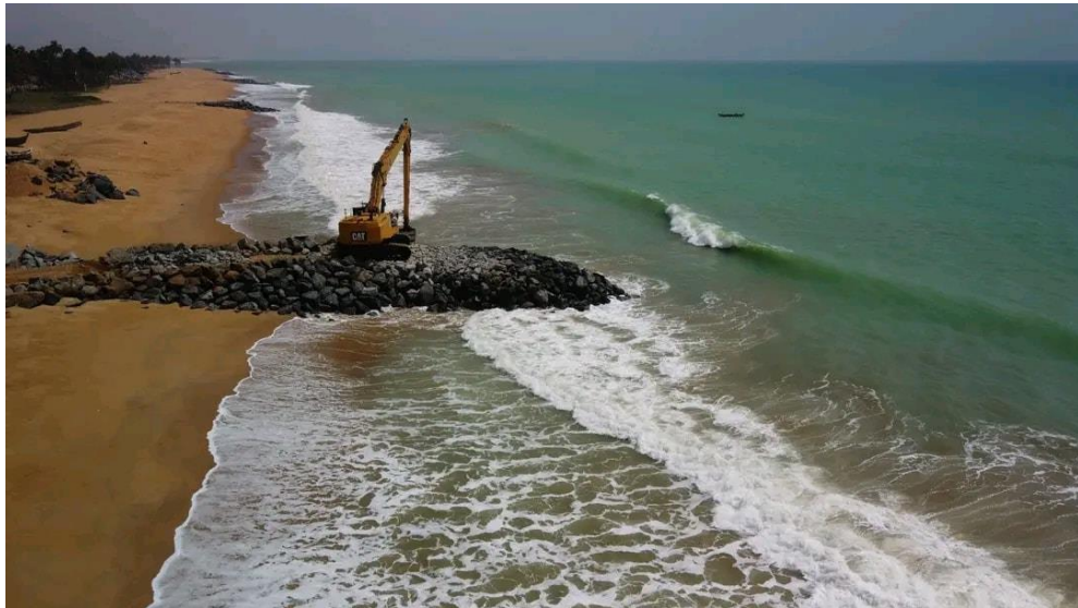
Photos 9. Travaux de pose d'épis à Agbodrafo (Commune Lacs 3)
