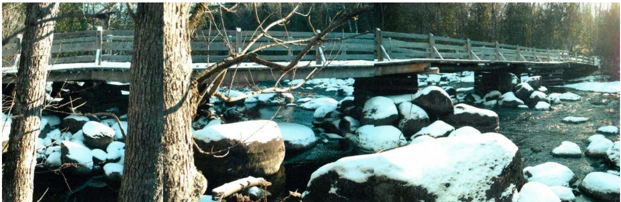
Figure 3.18 Photographie du pont prise peu de temps avant sa démolition (2012)
