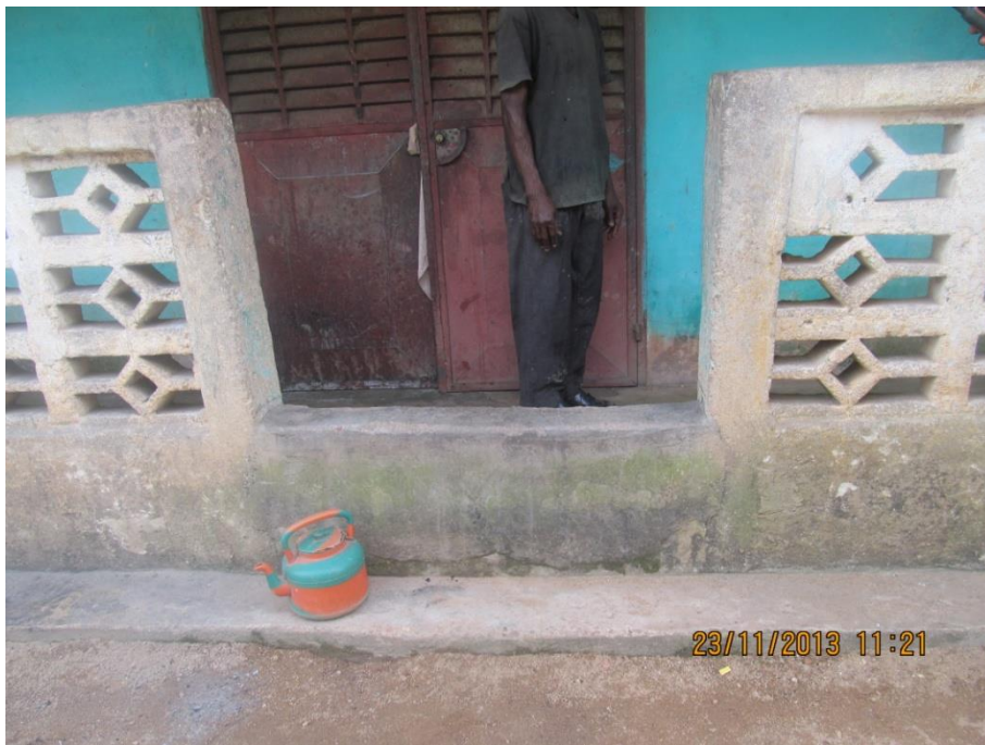
Contre soubassement construit à l'entrée de la maison après l'inondation de 2012
