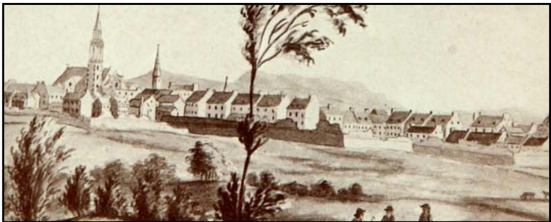
Figure 2.6 Les remparts au nord-ouest de la ville, entre les bastions Saint-Laurent et de la Poudrière en 1798
