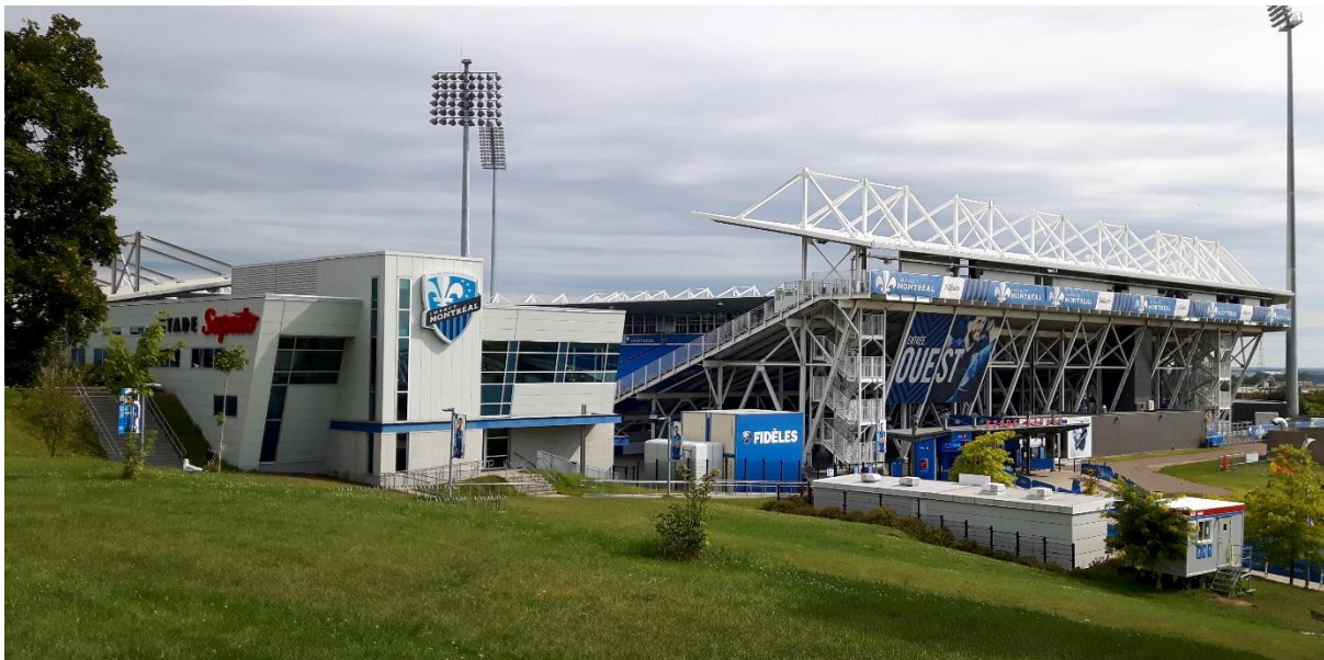
Le Stade Saputo, s'implantant au nord-est du Stade olympique, transforme la piste d'athlétisme en stade de soccer.
