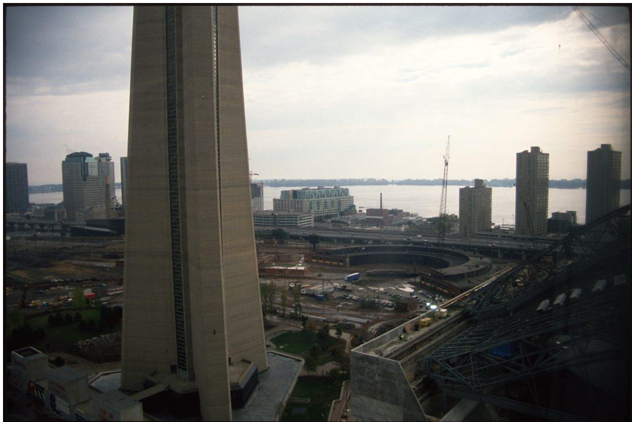
Figure 5.3 Vue vers le sud-est à partir du site du Centre Rogers
