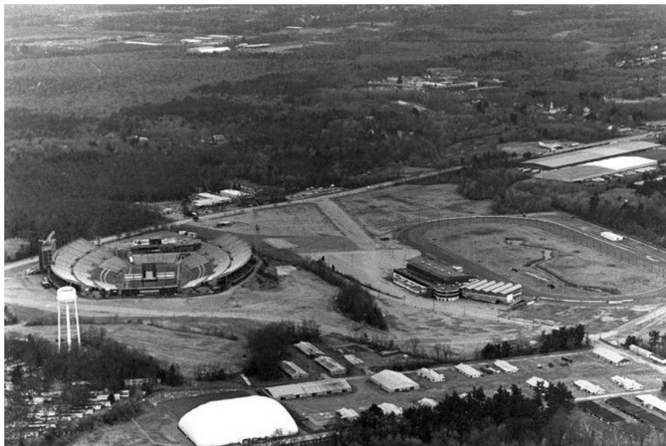
Figure 6.2 Vue aérienne du secteur en 1992
