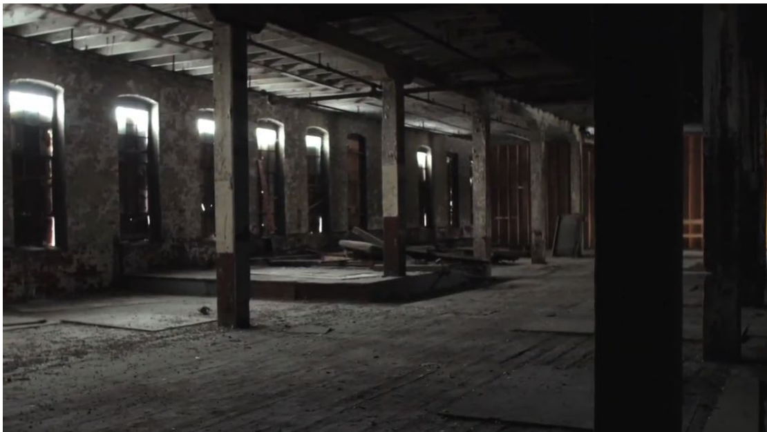
Figure 3.10 : L'intérieur du deuxième étage de la Tonnellerie
