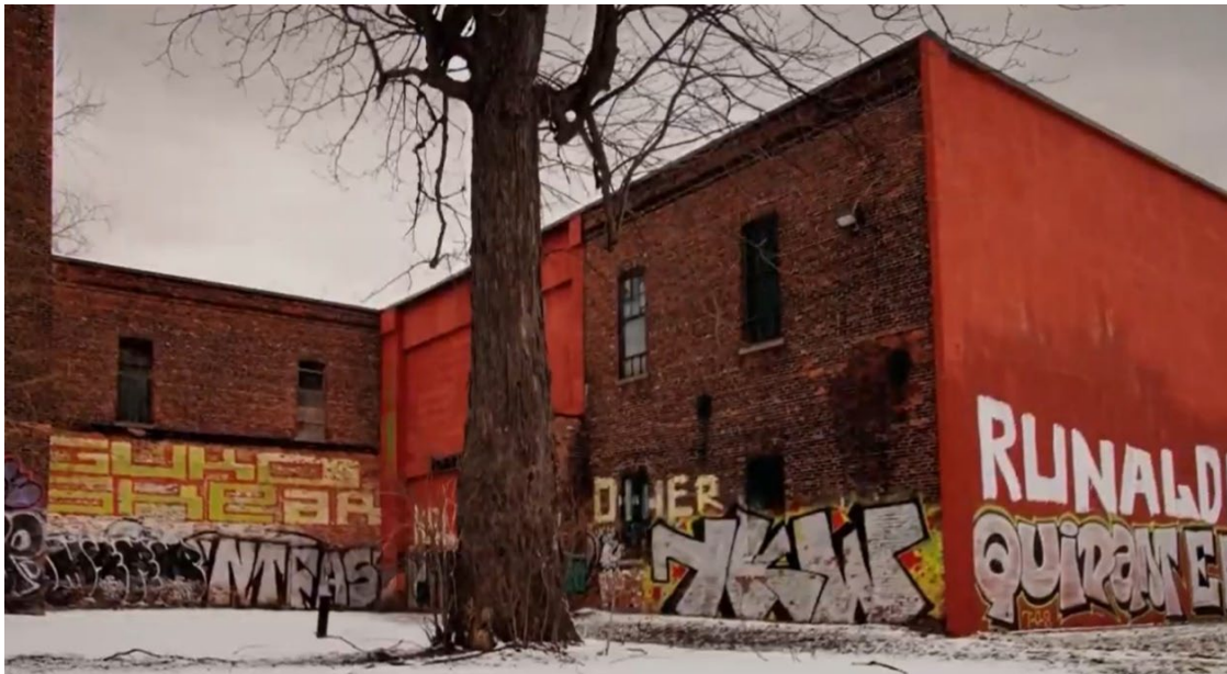
Figure 3.7 : La Tonnellerie et son mur en contreplaqué, à droite
