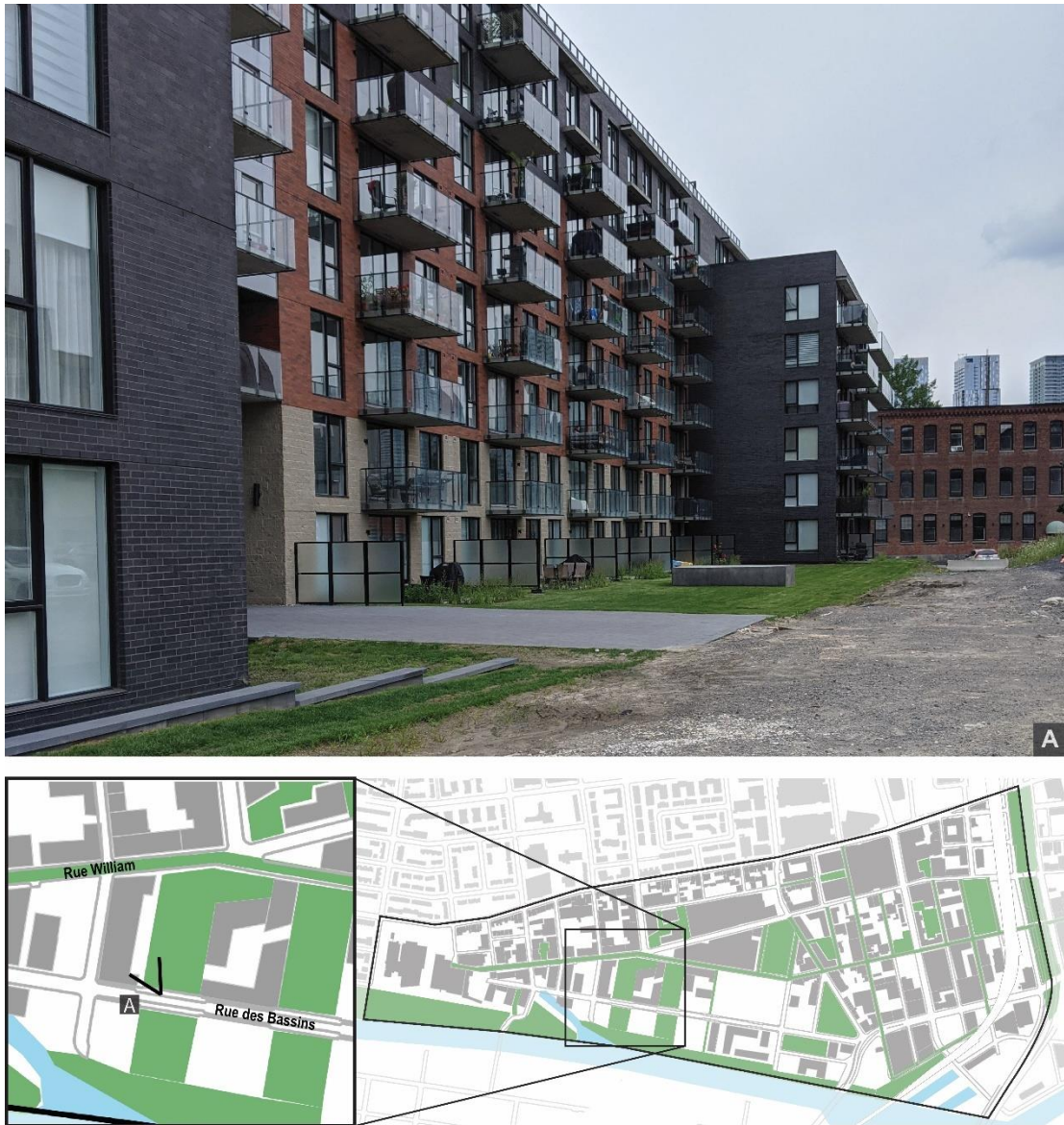
Figure 4.15 Terrasses au rez-de-chaussée du projet résidentiel « Bass »
