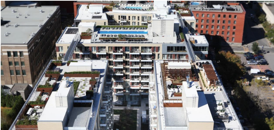
Figure 4.22 Toits-terrasses du Lowney, phases 8-11 (Prével, 2020)
