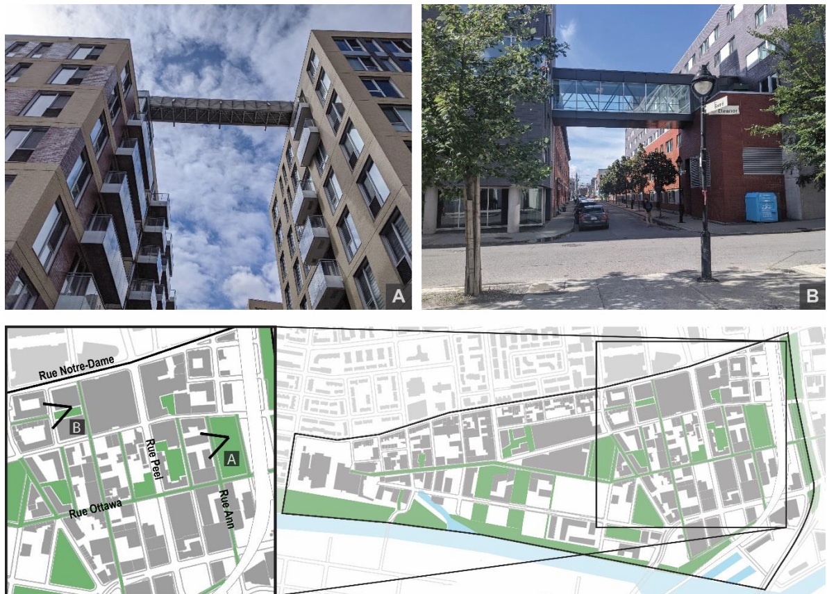
Figure 4.23 Passerelles entre les bâtiments du Lowney (A) et des résidences étudiantes de l'ÉTS (B)
