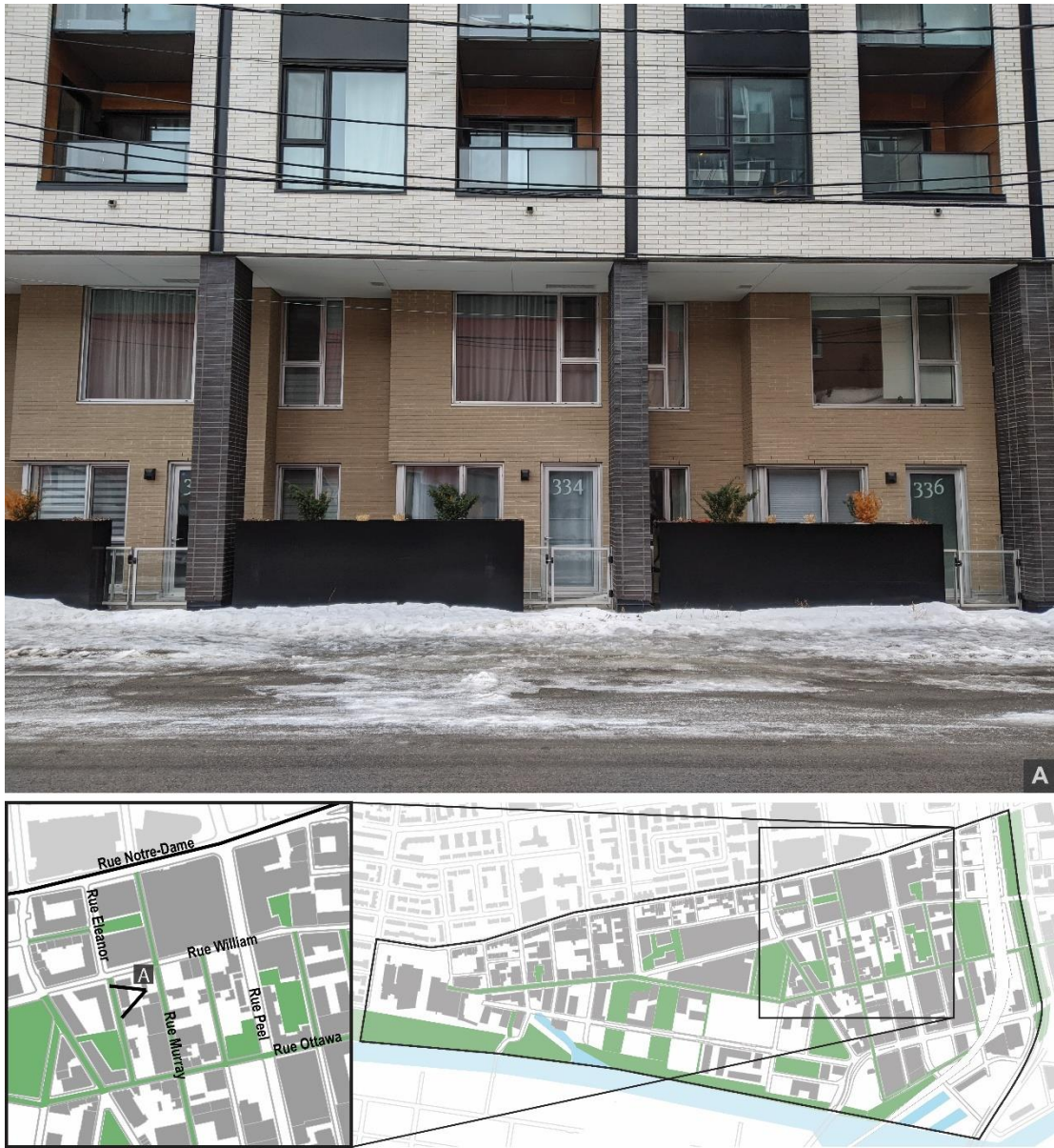
Figure 4.8 Façade mixte de la rue Eleanor
