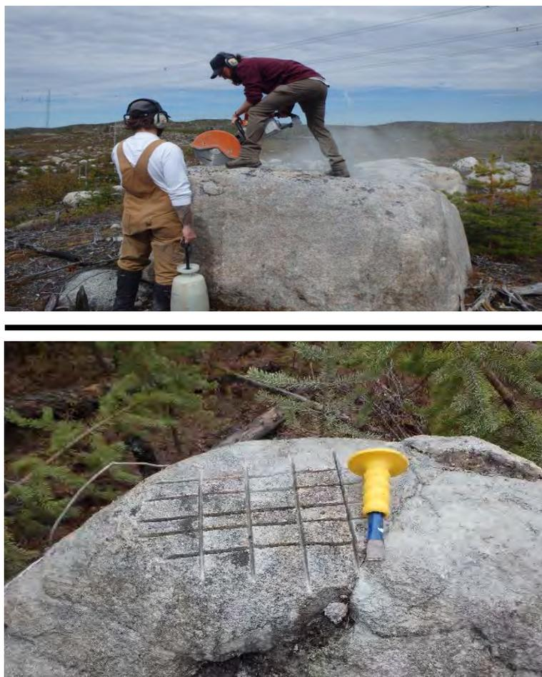
**Figure 2.4.** La photo du haut montre le sciage d'un bloc erratique reposant sur la moraine de Sakami. La photo du bas montre le bloc après incision à la scie permettant de récolter les fragments de roches à l'aide d'une masse et d'un ciseau à froid.
