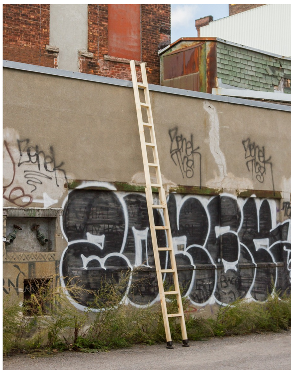
Figure 3.4 Une des échelles d' Accès
