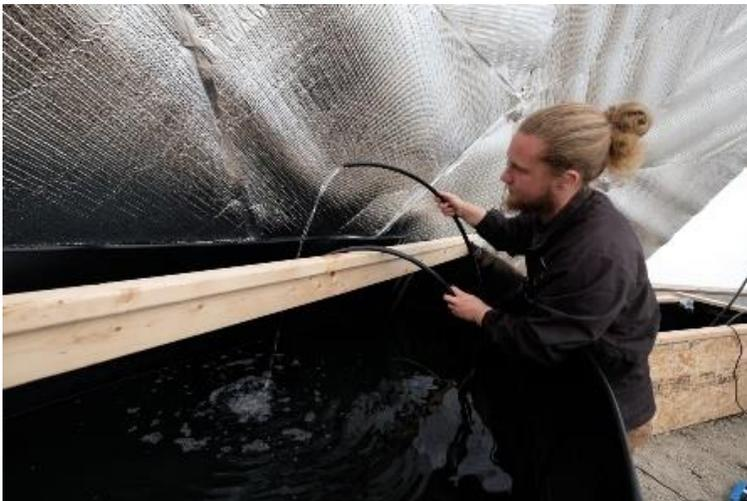
Figure 5.41 Bassin d'eau radiateur de chaleur lors d'un remplissage
