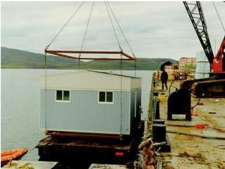
Figure 6.11 *Maison préfabriquée soulevée à l'aide d'une grue pour l'enlever d'une plateforme flottante en provenance d'un transporteur maritime situé non loin du quai*
