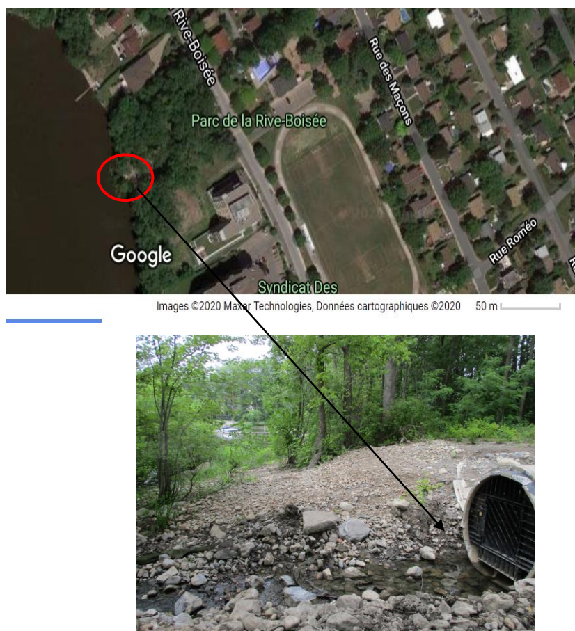
Figure 5.7 Vue de la sortie du tuyau de déversement au parc de la Rive Boisée Source : Observation de terrain et image satellitaire de Google 2020
