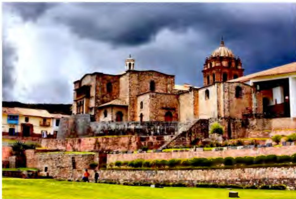
Annexe I : Palacio episcopal sur les fondations du Templo del Sol , Cuzco, Pérou. Source : http://www.panoramio.com/photo/17680668
