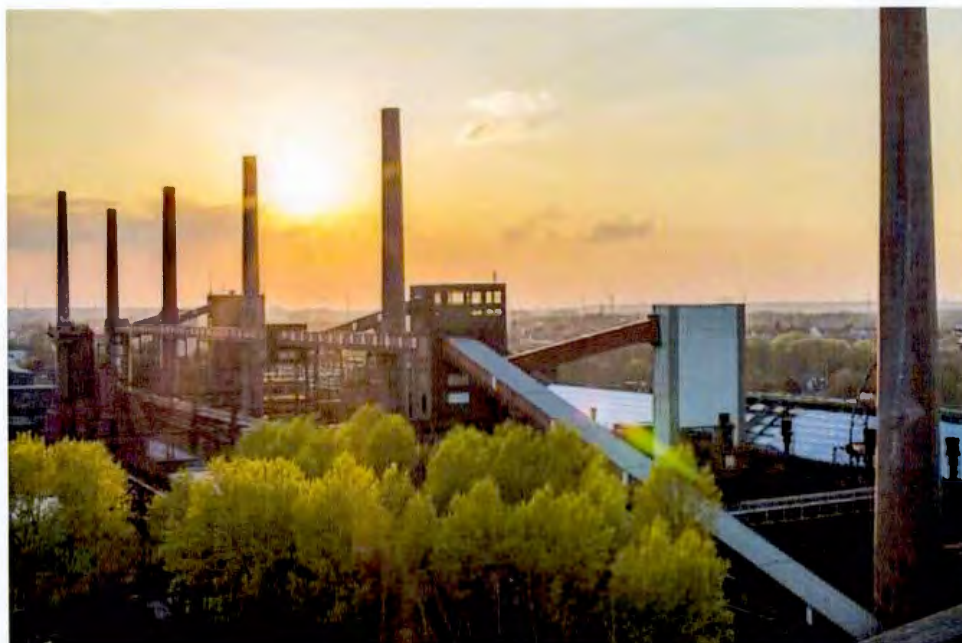
Figure 11. Les six cheminées d'environ 100 m de hauteur intégralement préservées sur le site de Zollverein. Source image : Jochen Tack, Stiftung Zollverein (La Fondation Zollverein).
