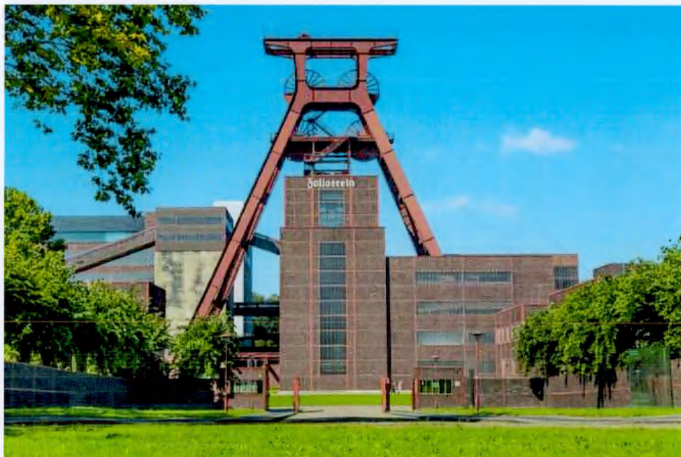
Figure 10. Le chevalement en acier à quatre roues de type portique du puits XII de Zollverein. Source image : Jochen Tack, Stiftung Zollverein (La Fondation Zollverein).
