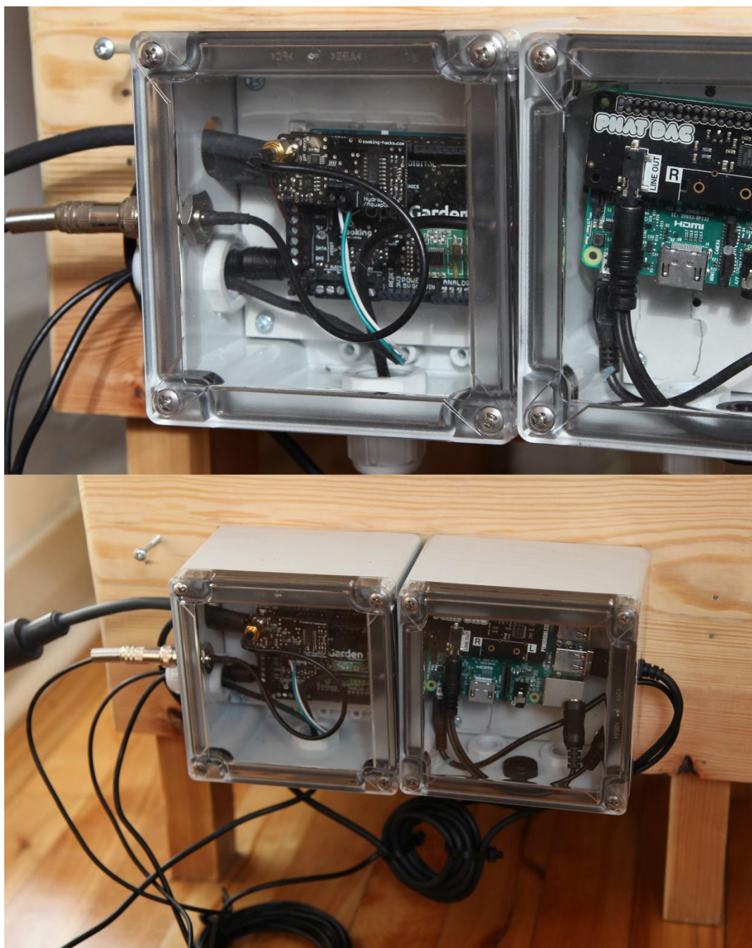
Figure 21 – Aquaphonie - Matériel électrique et électronique dans des boîtiers de 15 cm 3
