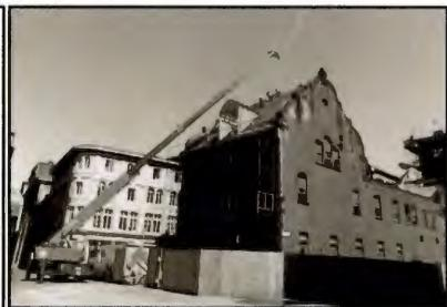
Figure 5.1c Reconstruction de la lucarne lors des travaux de rénovation en 1980-1981. Photographie CHM ©
