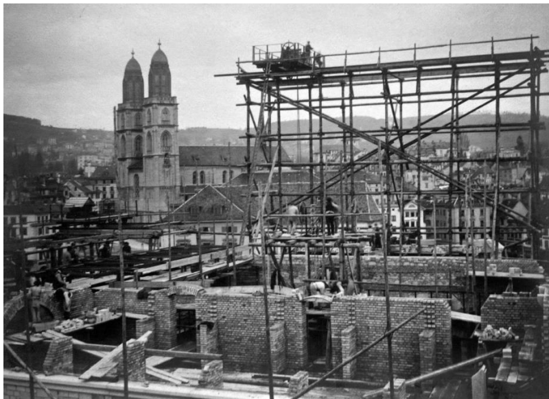
Figure A19 : Anonyme, Chantier de l'immeuble de bureaux Fraumünsteramt, Zürich, 1899. Crédit : Zentralbibliothek der Stadt Zürich, Graphische Sammlung, succession Robert Breitingner).
