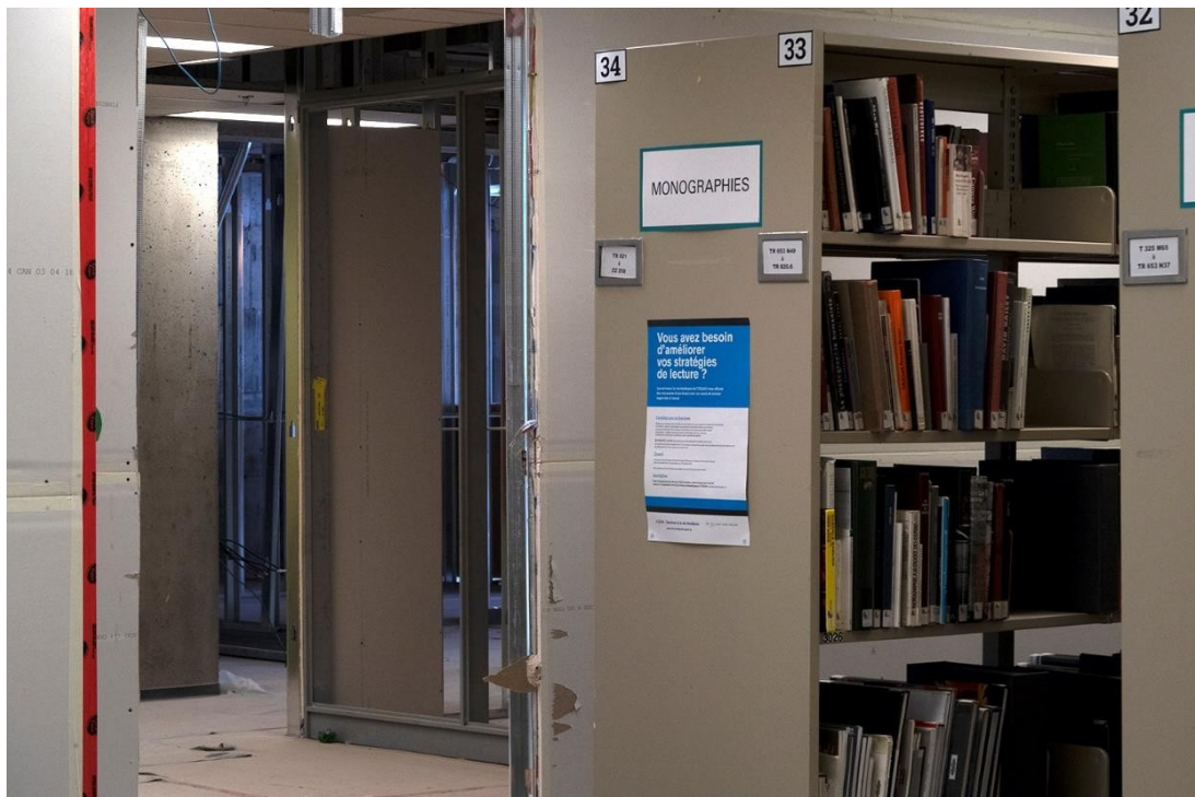
L. Rocher, Chantier de la bibliothèque de l'UQAM , juillet 2018.
