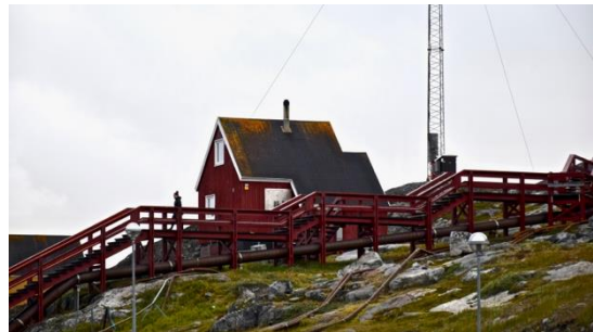
Figure 6 : Couplage d’un escalier urbain à des tuyaux de distribution d’eau
